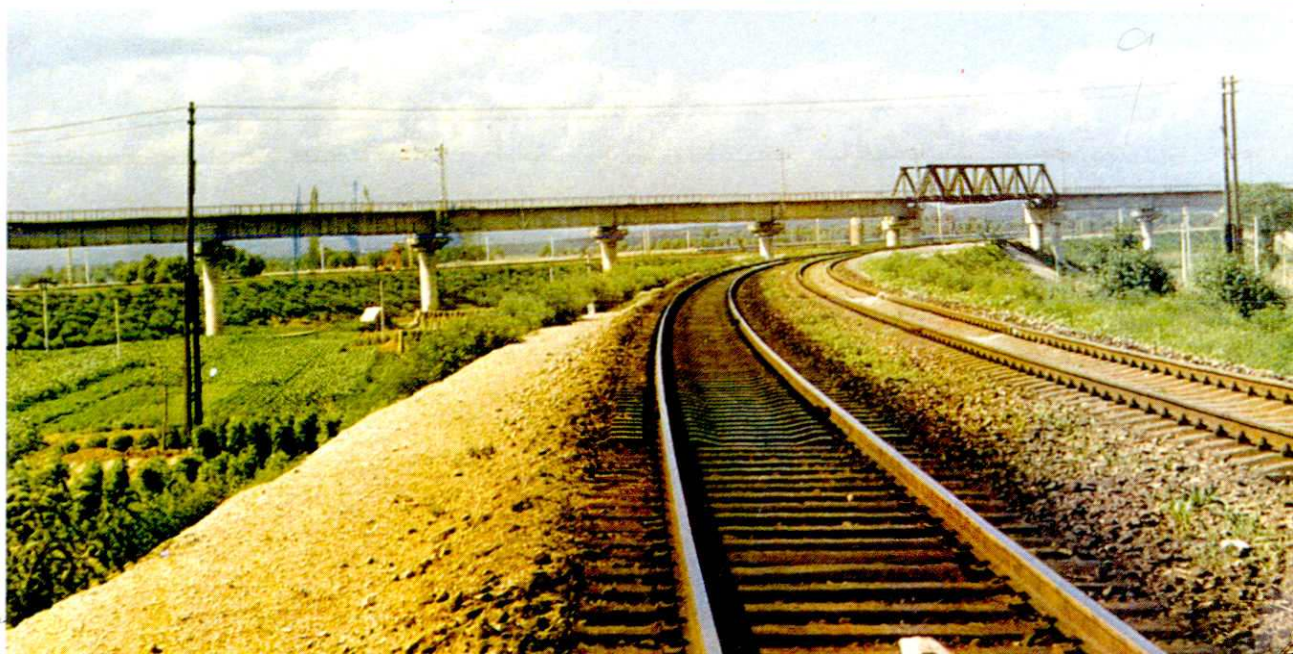
京山、京秦铁路汤河特大桥
