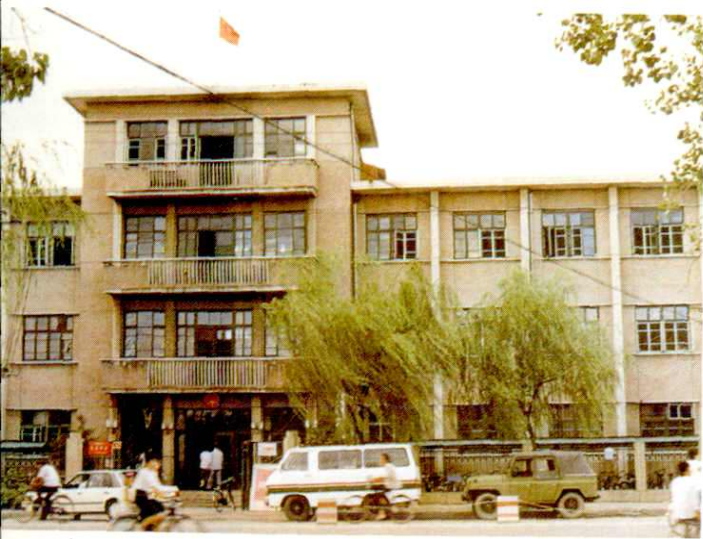
海港区政府办公楼
