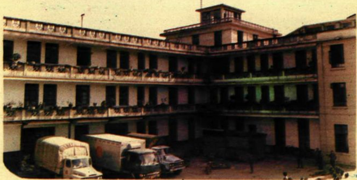
保山邮电综合大楼内侧
