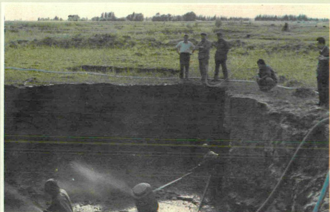
▲水产良种场利用泥浆泵挖鱼池
