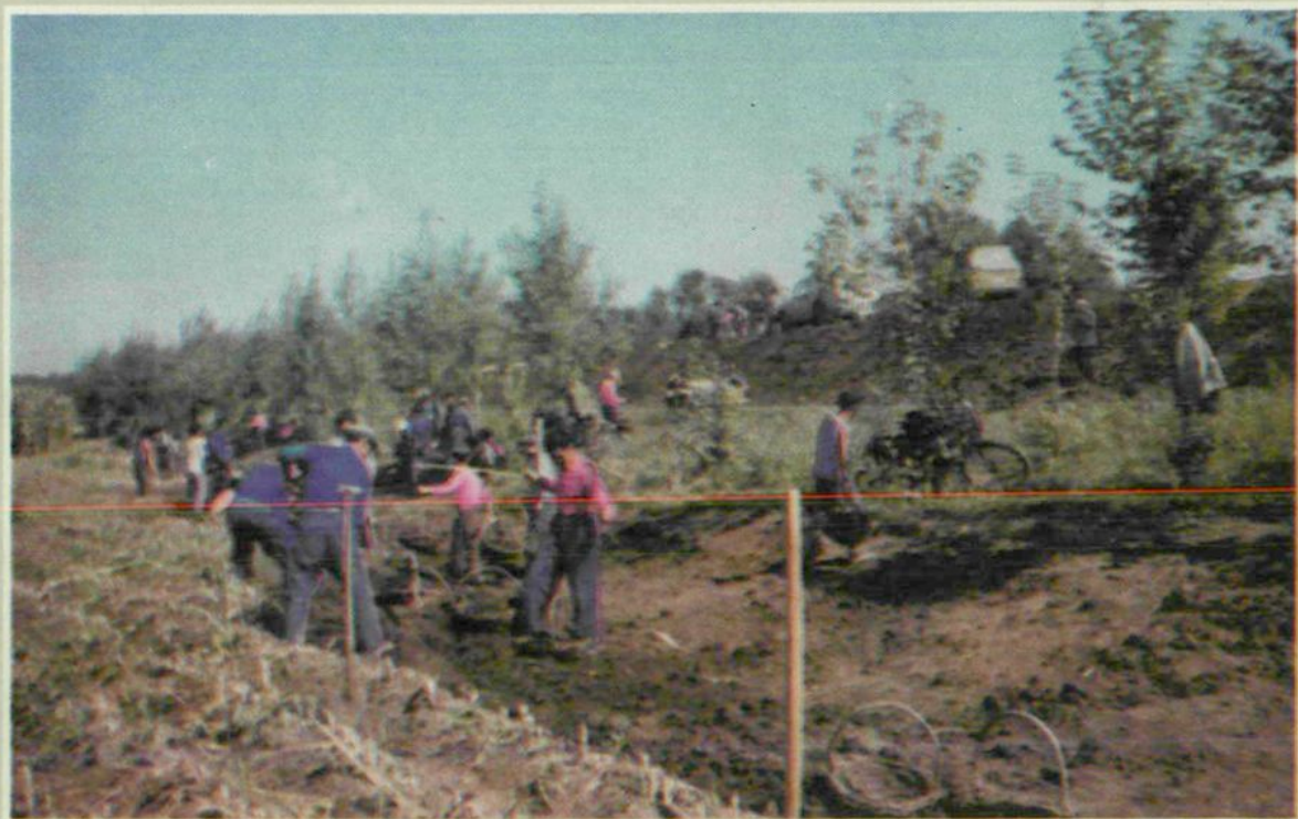
▼东辽河南崴子乡堤段整修加固
