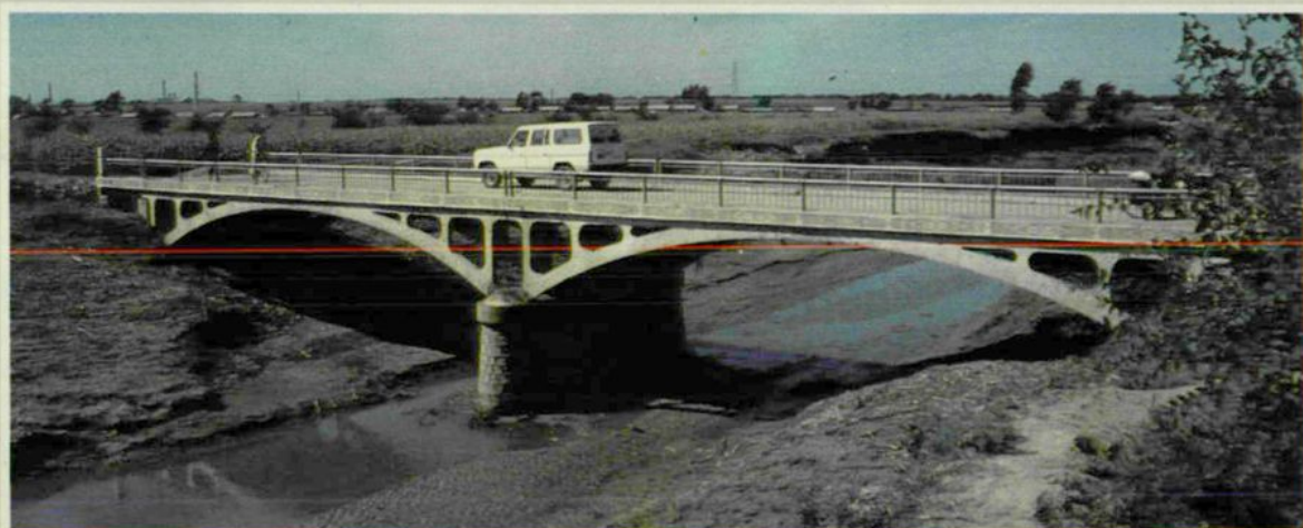
▲范家屯涝区山东屯桁架拱桥
