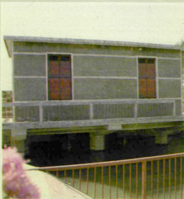
▲ 范家屯涝区方正排涝站
