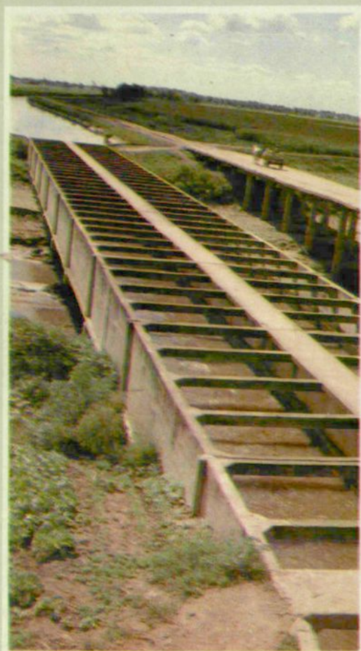
▲ 秦家屯灌区张花屯渡槽
