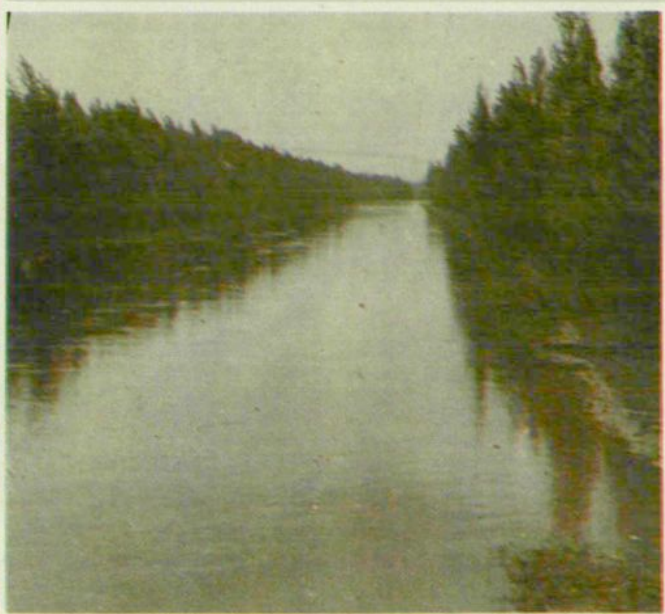
▲ 大岭涝区排水主沟
