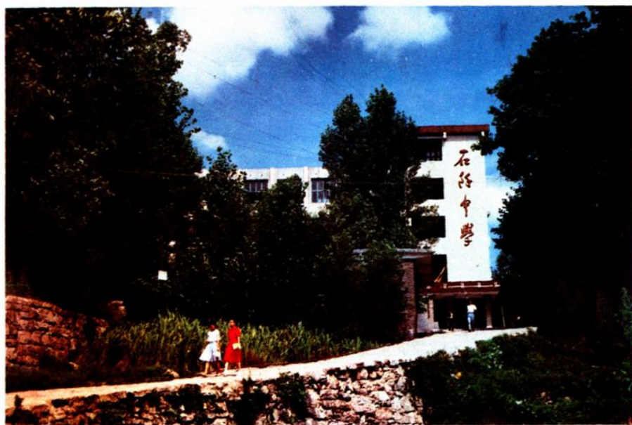
石阡中学综合大楼 刘家伦摄
