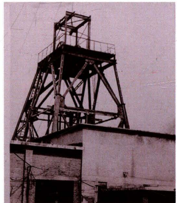
1938年建设的烈山煤矿
