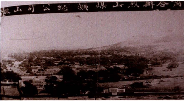
民国时期官商合办烈山煤矿总公司山厂全景
