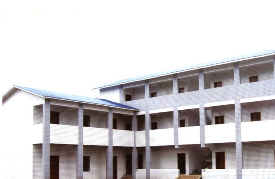
重庆市级示范工程万寿村康居工程
