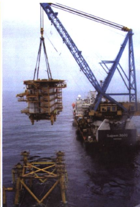
建设中的气田
