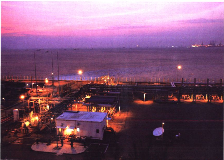
崖城13-1气田香港干气接收终端全景照片
