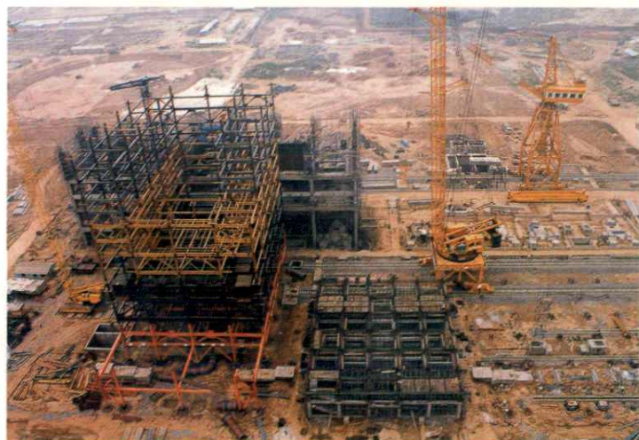
10 西柏坡电厂建设工地(高 潮供稿)
