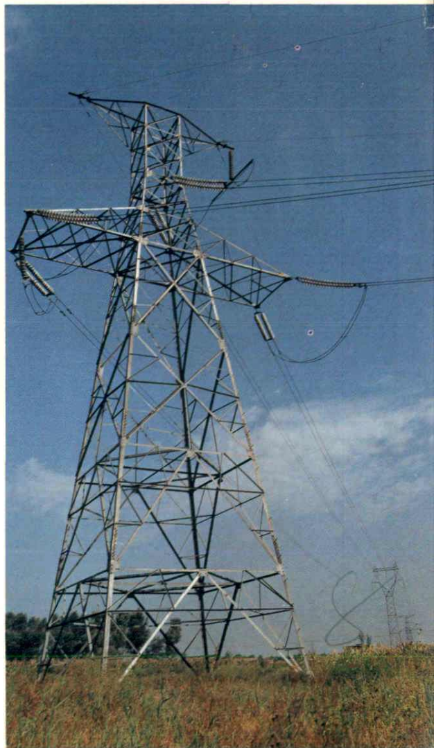
34 邢台王段至衡水220输电线路工程,获国家优质工程银牌奖。(梁占山供稿)(右图)
