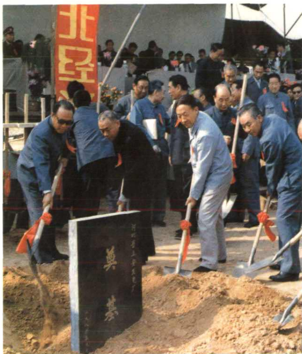
6 1986年10月,河北省和华能国际电力开发公司领导为华能上安电厂培土奠基(华能上安电厂供稿)
