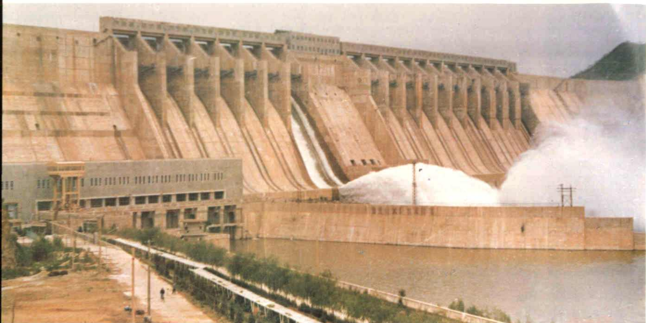
29 潘家口水电站,1981年4月第1台15万千瓦常规水轮机组发电,1993年2期扩建3台蓄能水轮机组建成,全站容量43万千瓦。(高潮供稿)
