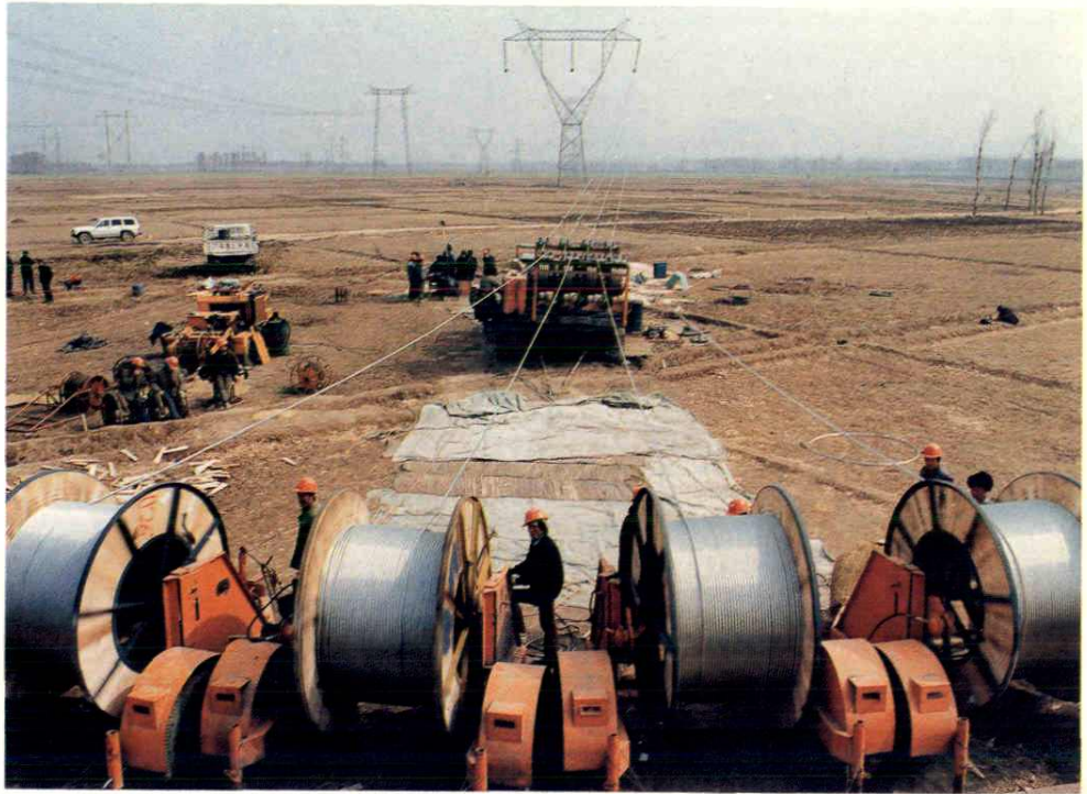
15 500千伏线路放线(高潮供稿)
