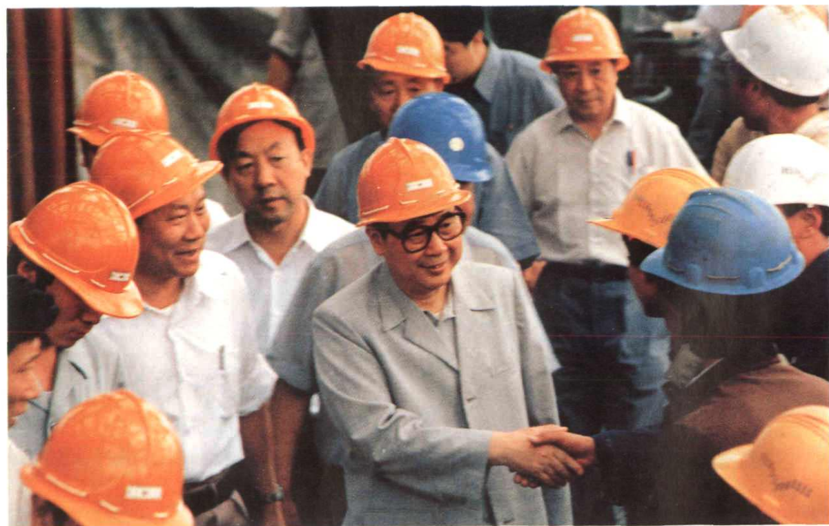
3 1988年6月,李鹏总理视察建设中的华能上安电厂
