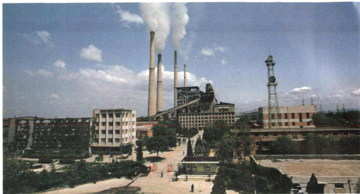
18 陡河发电厂,1976年4月1号机投产,现有机组8台,总容量155万千瓦(唐山发电总厂供稿)
