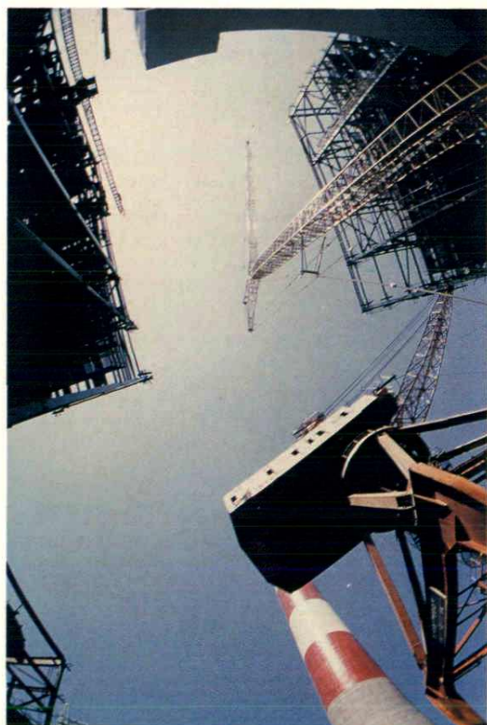
11 电厂建设工地一角(郭立秋供稿)
