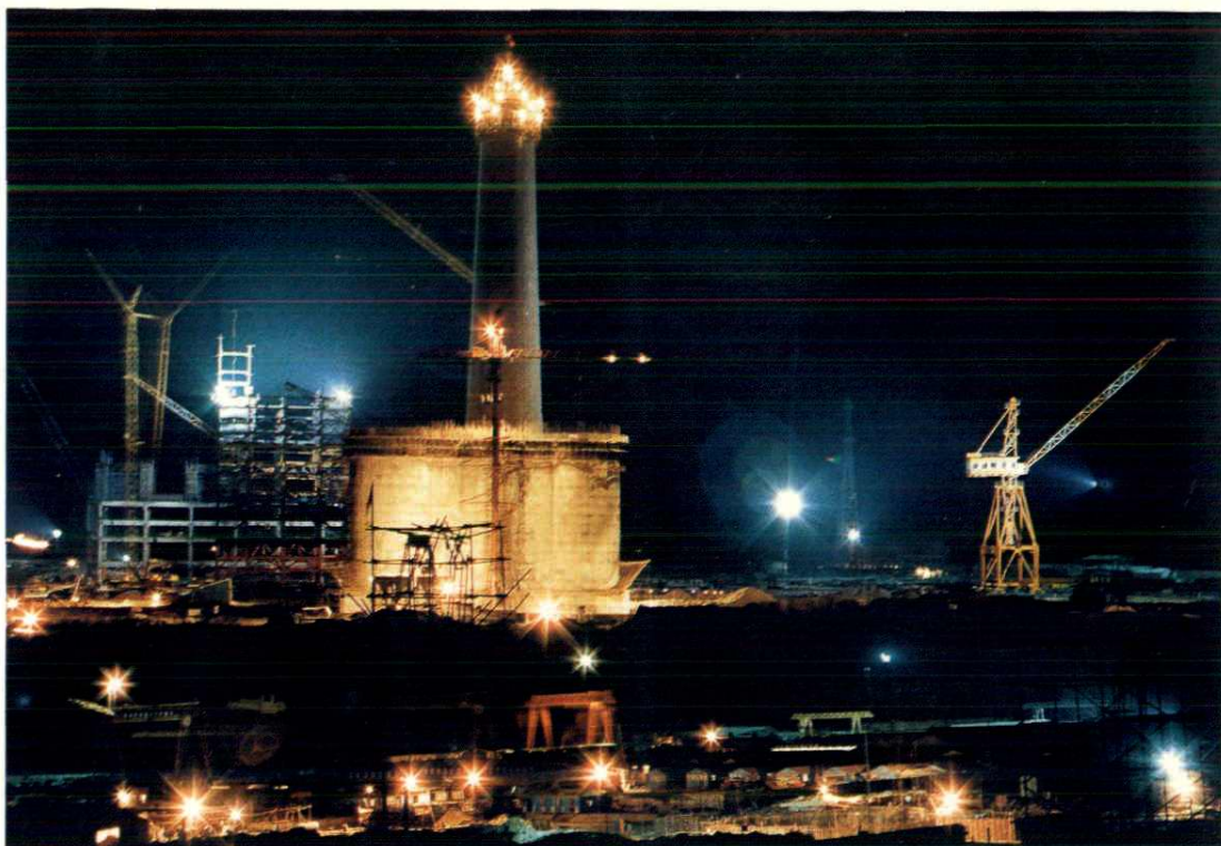
9 国家重点工程——西柏坡电厂(规划容量240万千瓦)建设工地夜景(孙 丁供稿)
