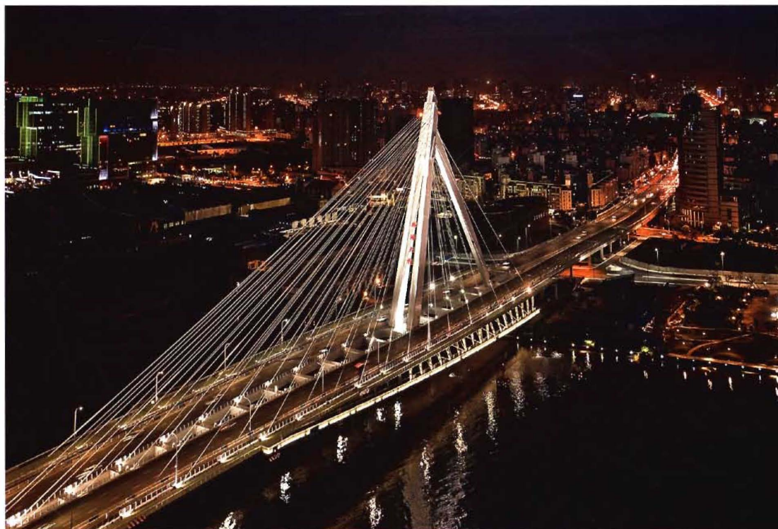
◇ 2010 年建成的外滩大桥
