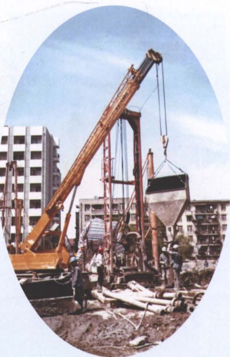
武汉桩基施工
