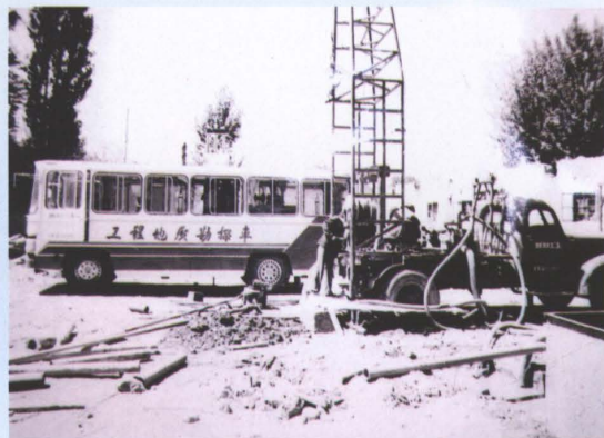
静力触探施工现场
