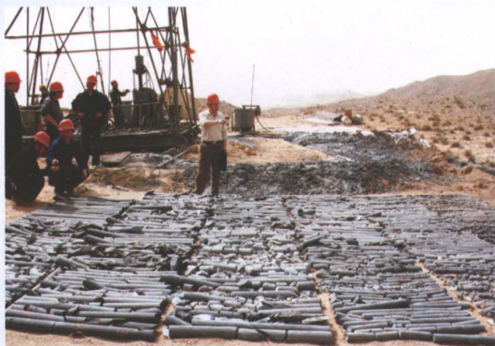
岩心钻探施工现场
