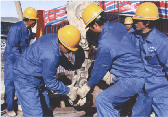
马鬃山供水井施工中（2005年）
