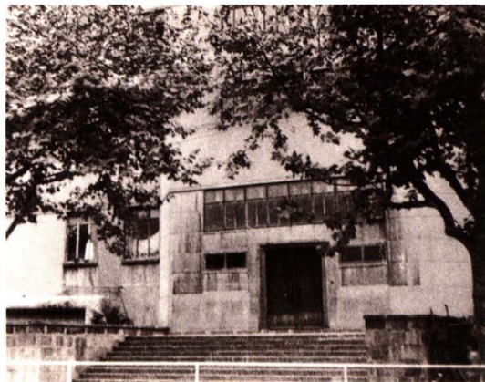
维多利亚疗养院大楼近照
