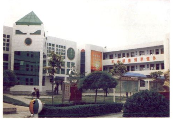
永城市实验高中教学楼
