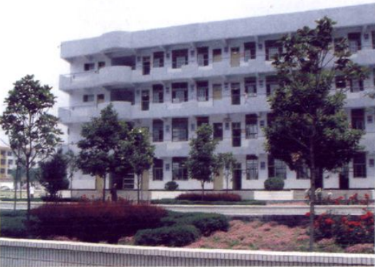
永城市实验中学教学楼
