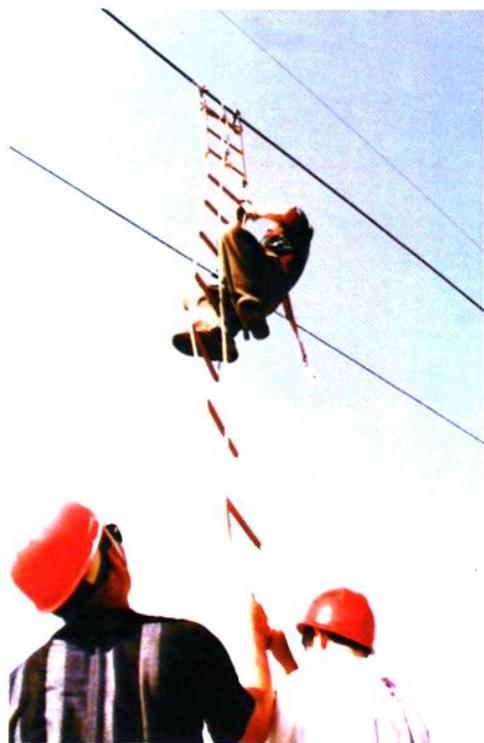
110千伏输电线路采用绝缘梯检修
