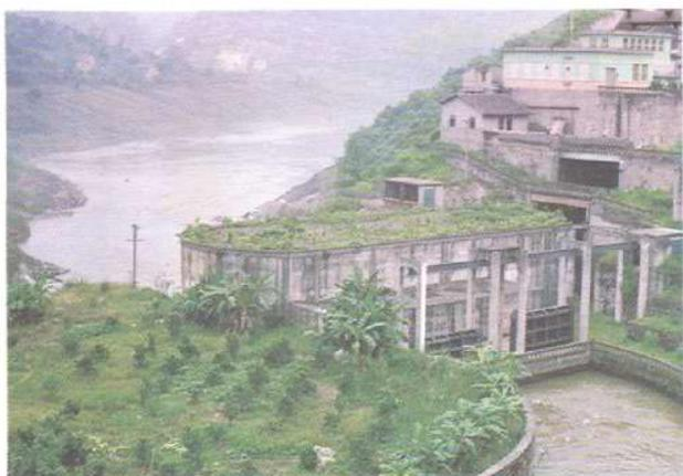
长寿运输桥水电站淹没式厂房
