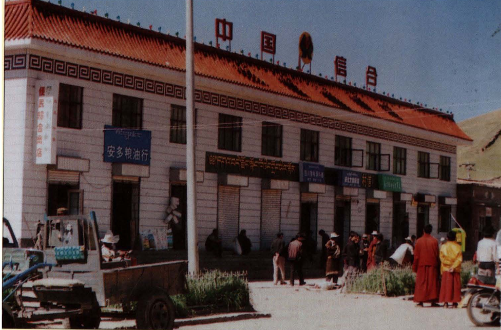
甘德县信用合作社大楼
