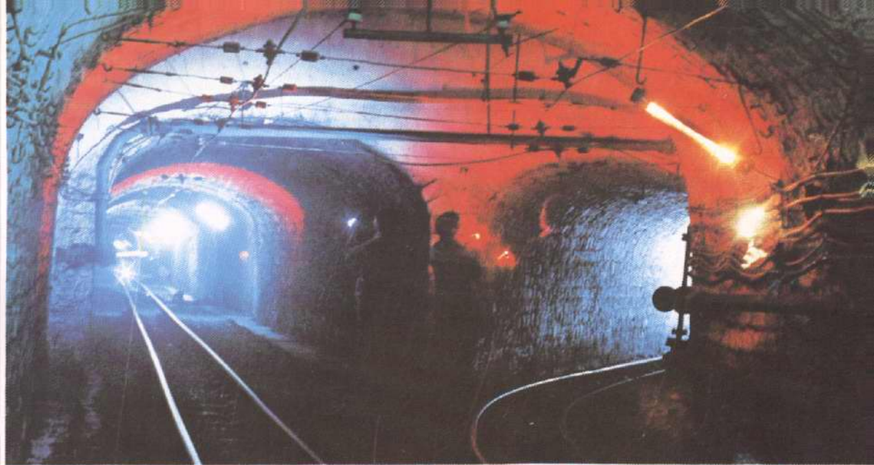
►架线式电机车运输巷道
