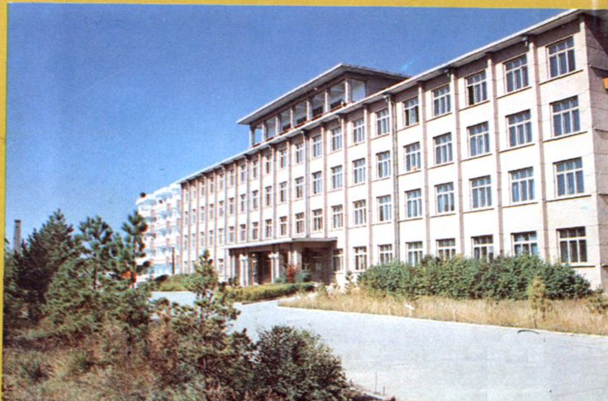
②呼盟党校教学大楼、宿舍楼。
