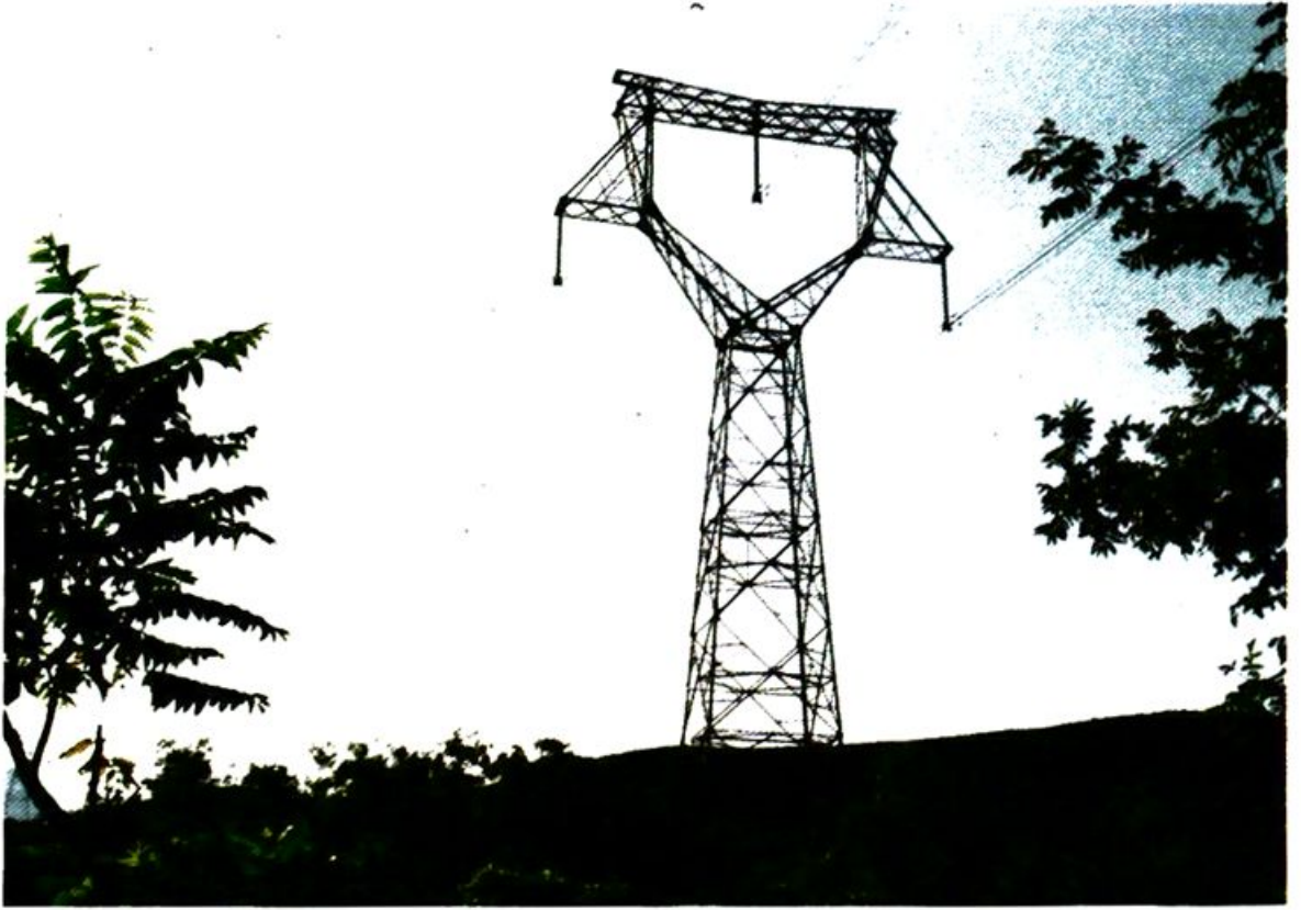
500 千伏洛繁线繁昌段铁塔
