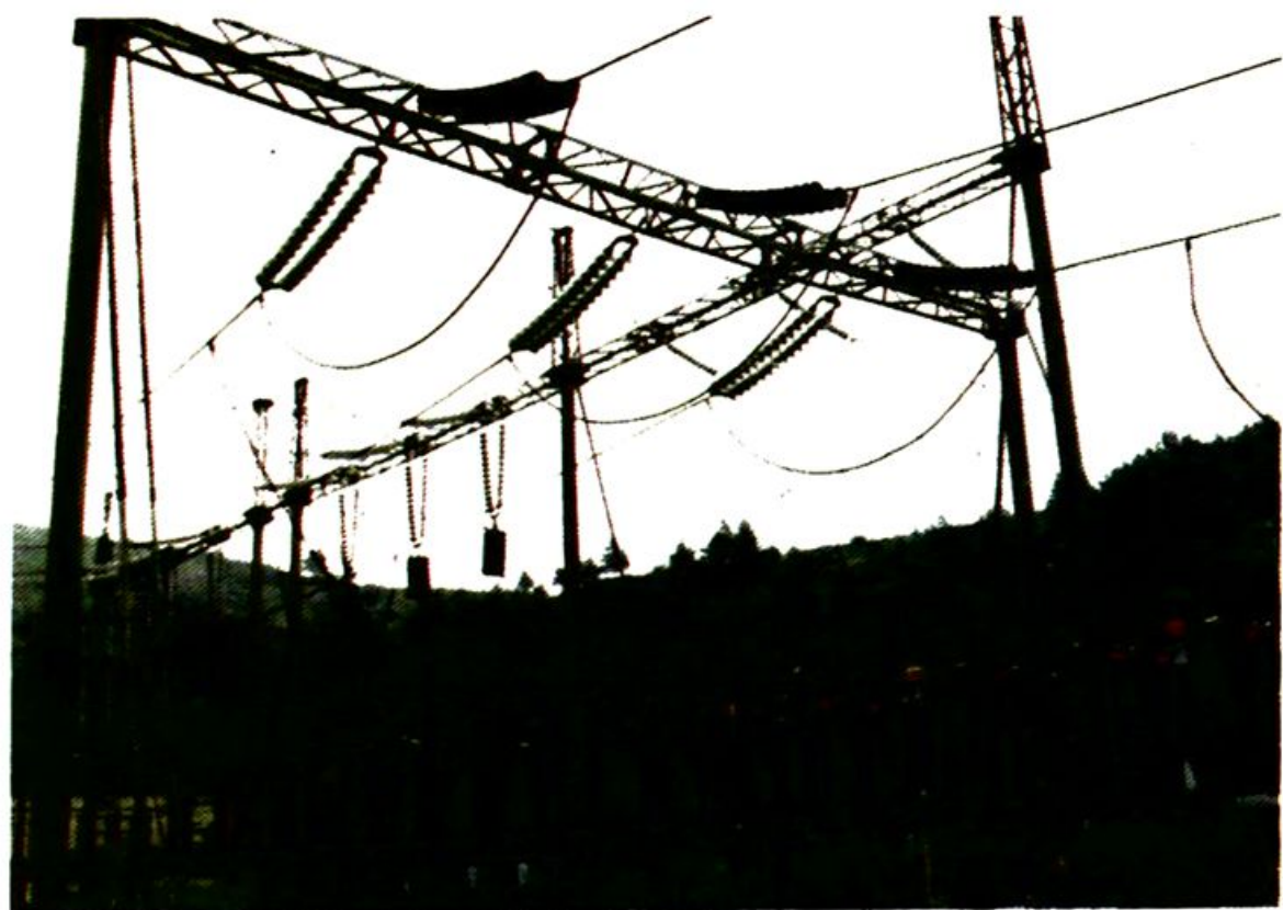
220千伏长龙山变电所开关群
