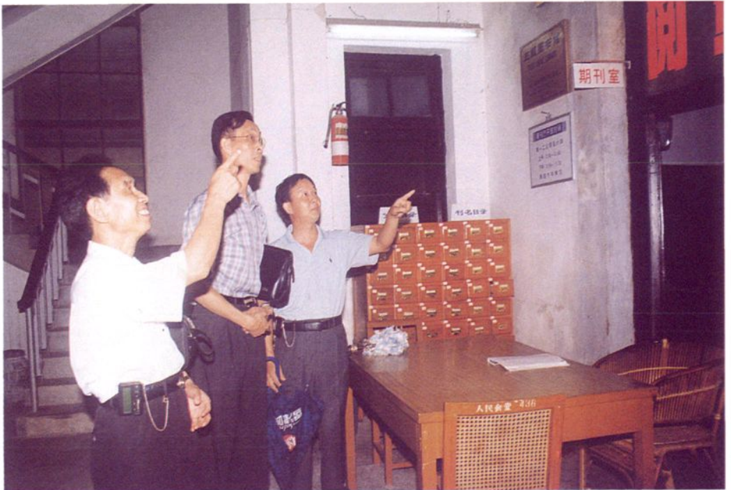
副局长陈世泰在福清市图书馆查看危房情况
