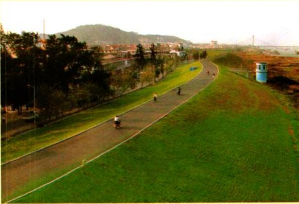
樵桑联围沙头堤段全长9.25公里，从1998年度开始，全堤按50年一遇洪水加高2米的设防标准完成达标整治，内容包括：堤身加高培厚，险段、窞闸除险加固，堤顶两边砌路缘石、铺设沥青砼路面，内、外坡种植大页油草等，工程总投入2400万元。
