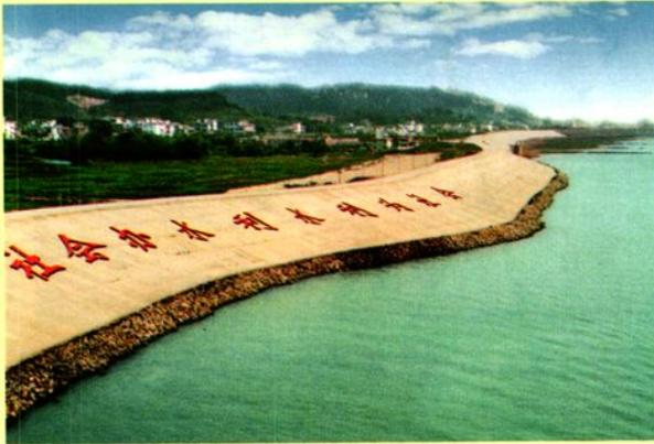
佛山大堤小塘堤段长10.4公里，其中曾于1994年6月洪水出现险情的大凶段长200米。全堤段已整治加固，按50年一遇超高2米的标准培修。
