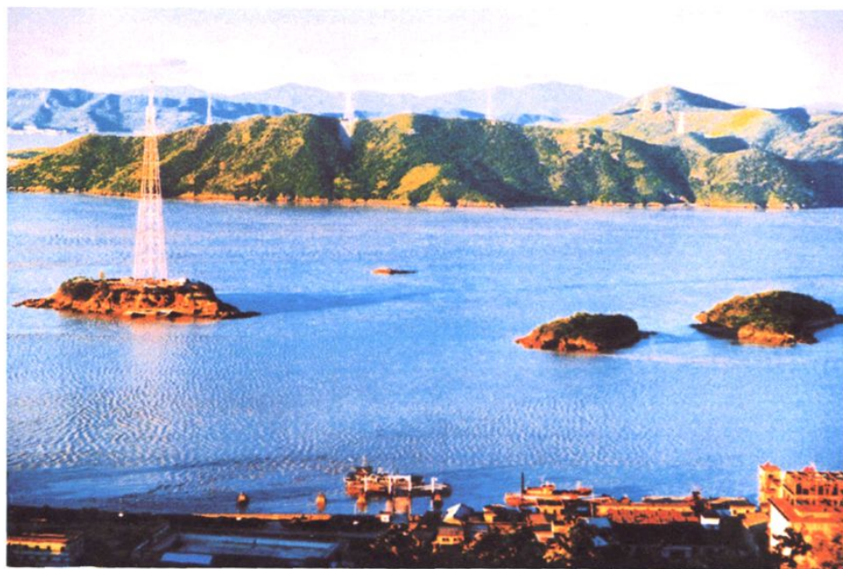
岱山与舟山海岛电力联网工程
