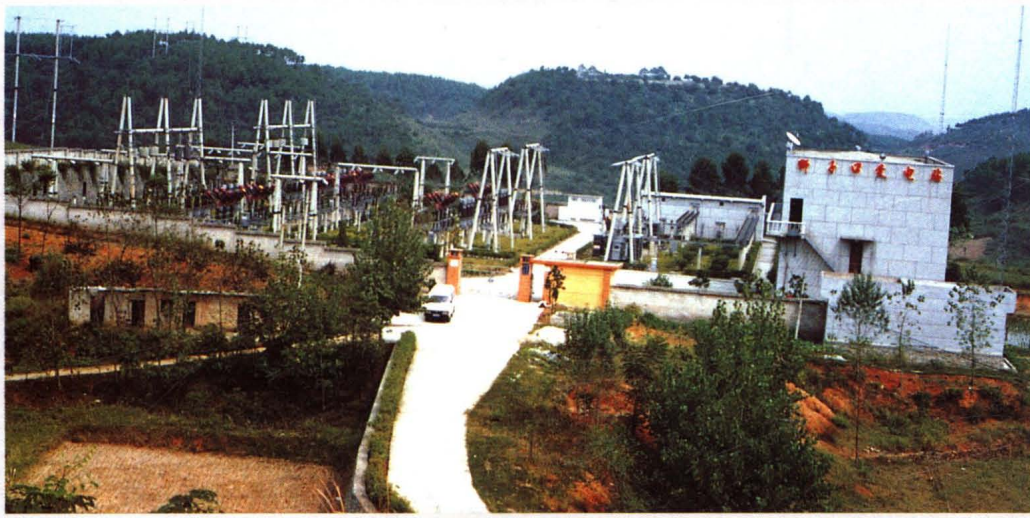
玉屏220KV变电站外景,主变容量 1 \times 9 万+ 1 \times 12 万kVA
