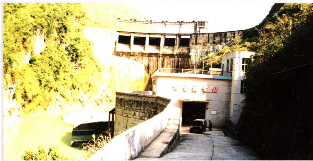
印江甘 金桥水电站 外景
