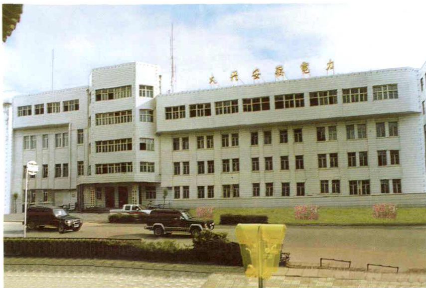
电力局机关办公楼
