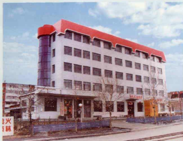
漠河发电厂、供电局办公楼
