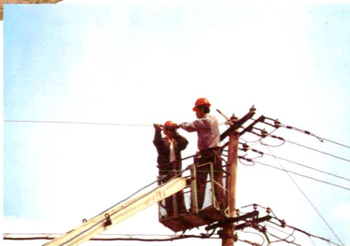
供电工人线路抢修
