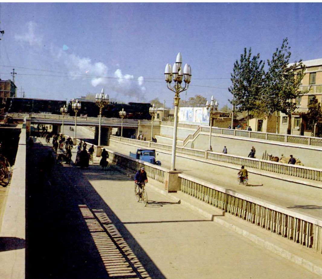
榆次市西顺城街立交桥
