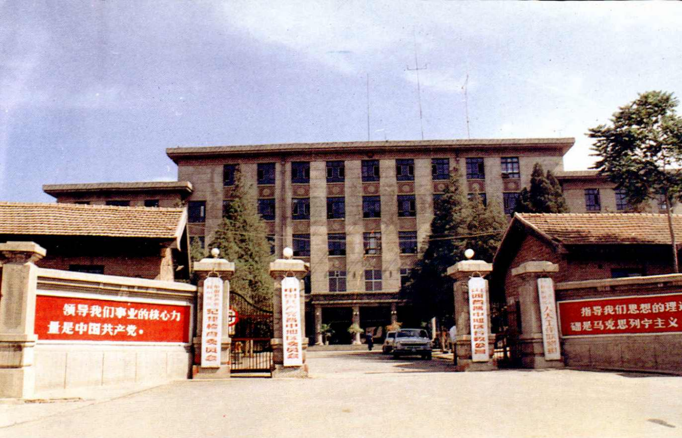
晋中地委、行署机关主楼
