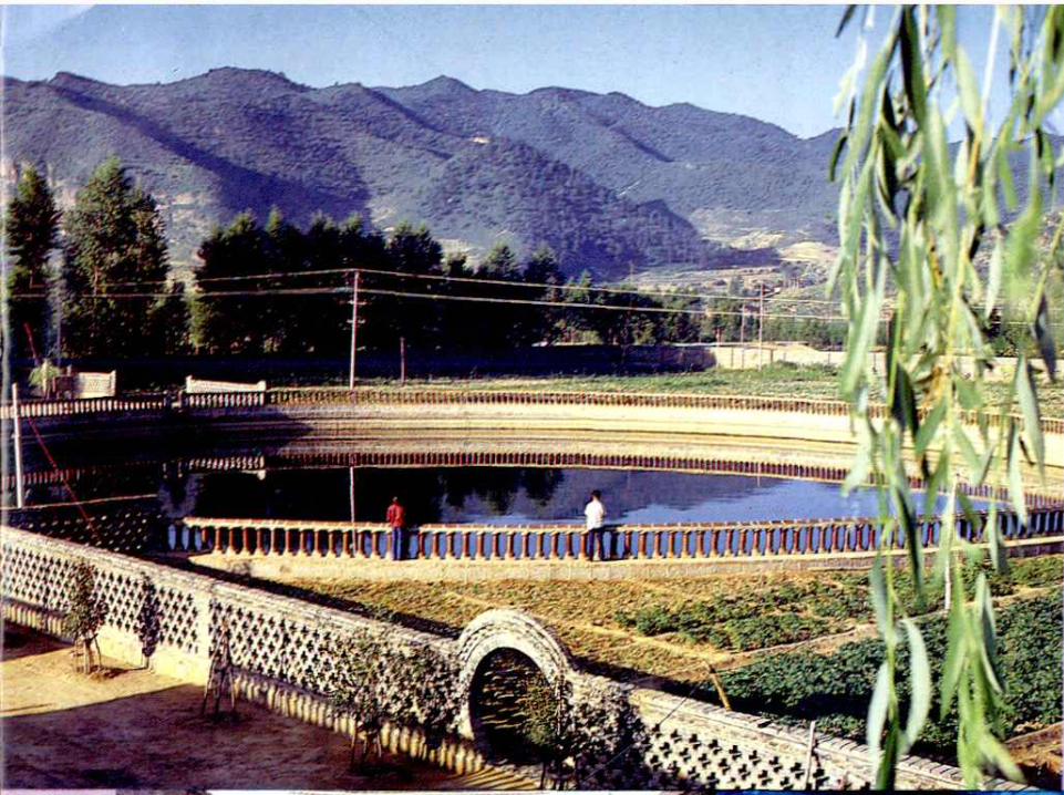
和顺县提水工程
