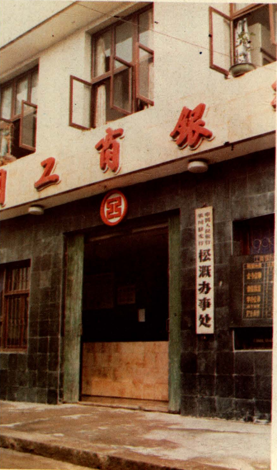
◀ 中国人民银行永川县支行松溉办事处
