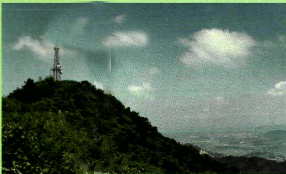
临湘市五尖山的移动电话通信基站
