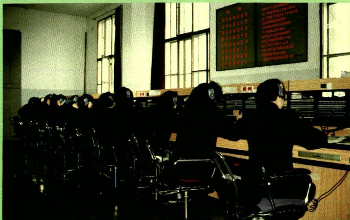
程控电话开通之前的长途电话磁石人工交换机房
