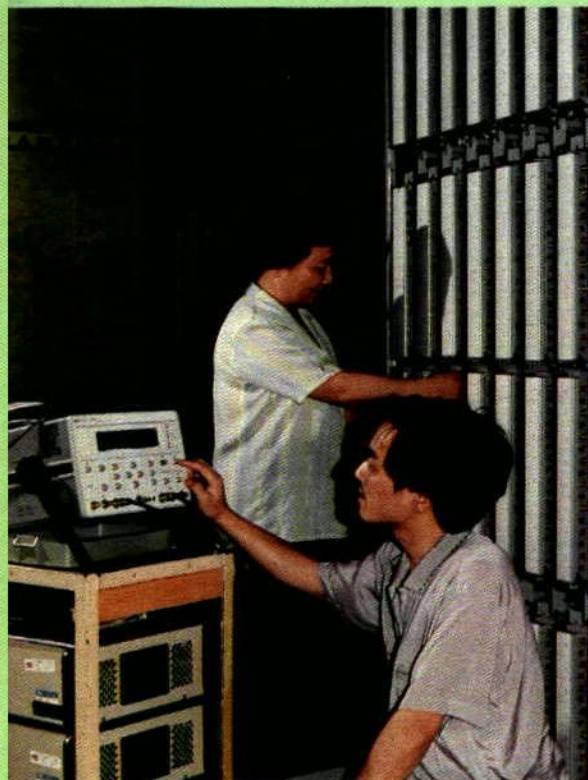
岳阳市邮电局长途电话传输检测中心 岳阳市邮电局移动电话机房工作人员 在装数据磁带 (右上)
