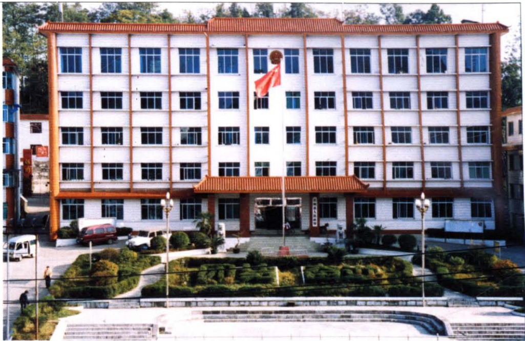
县人民政府办公楼
