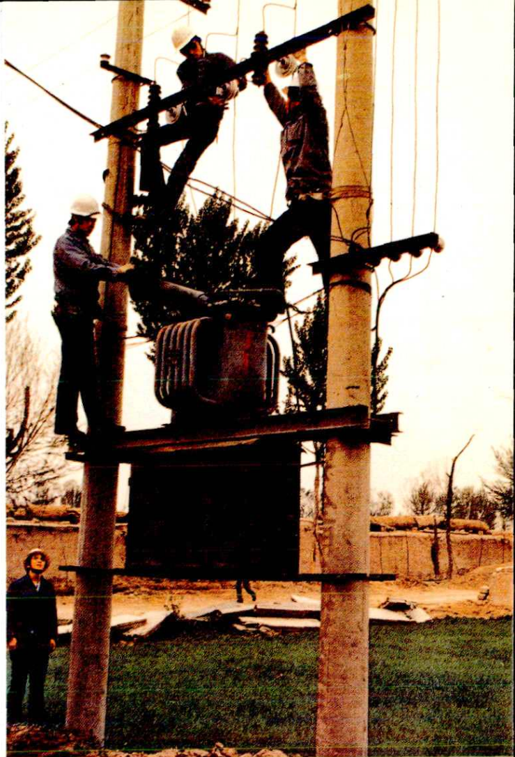
帮助用户修复电力设施
