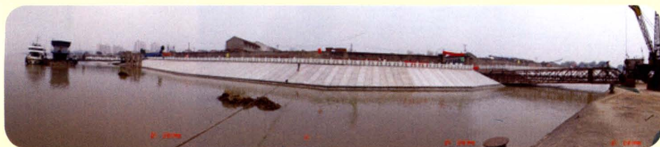
鼓楼区长江沿岸实施血防水利护坡工程。
