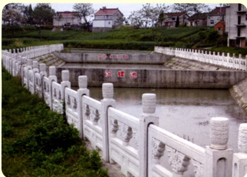
实施血防水利沉螺池工程。
