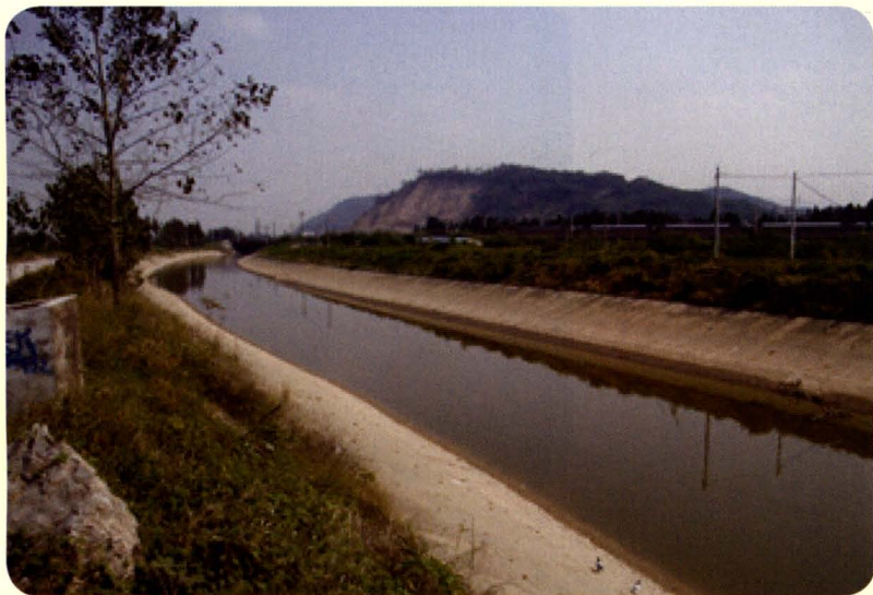
通江河道实施血防水利护坡灭螺。
