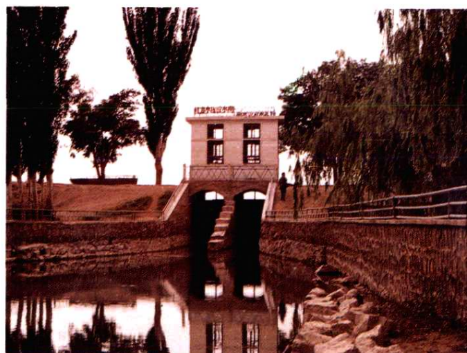
阿勒库勒水库放水闸
