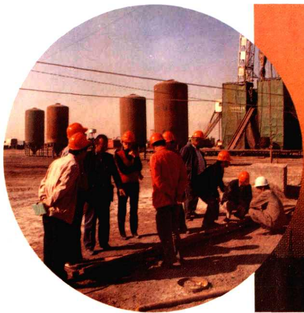
境内石油勘探
