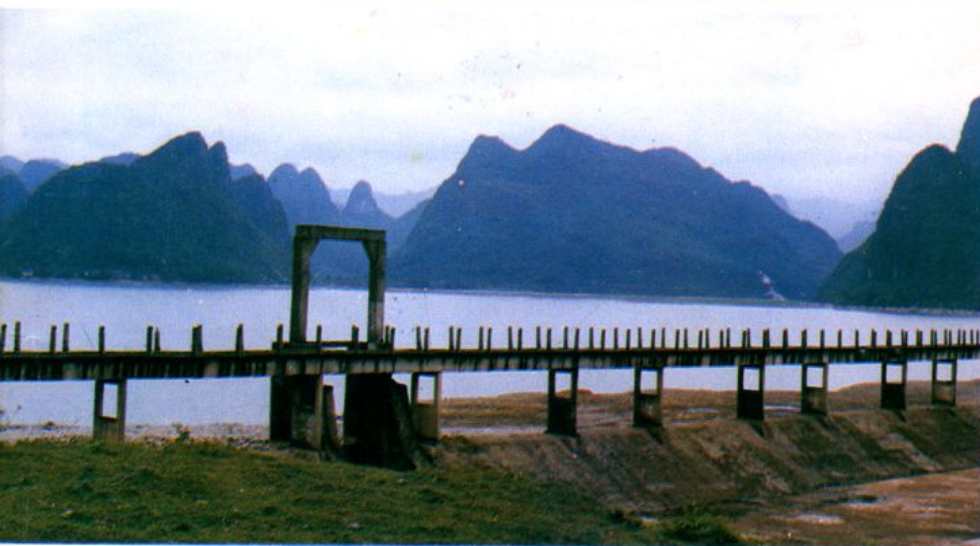
金鸡河水库溢洪道
