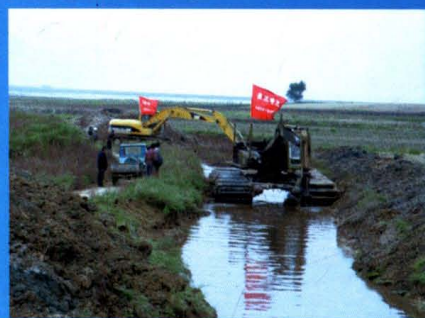
常硝渠开挖现场
