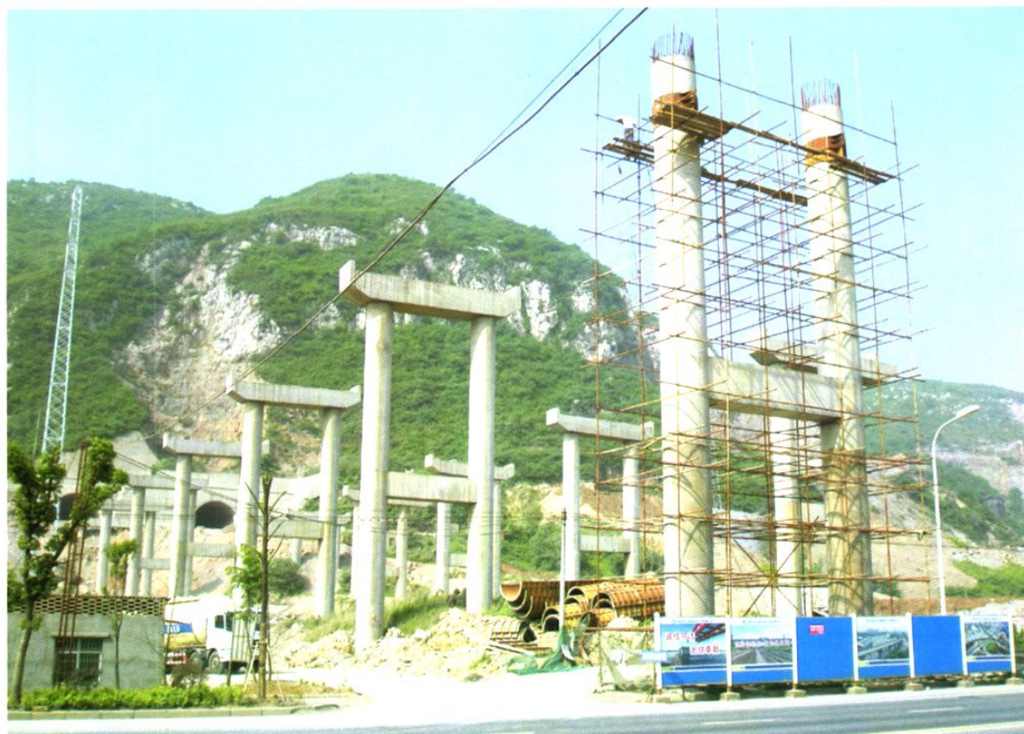
正在施工建设中的大庆至广州高速公路高架桥
