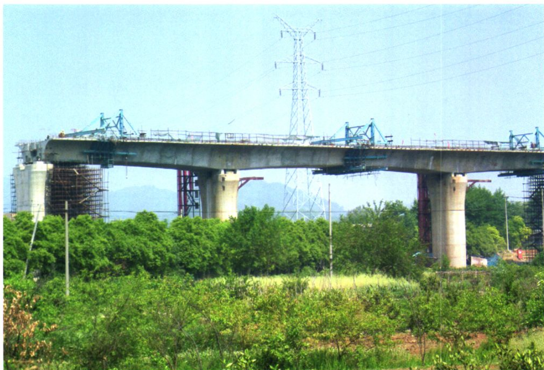
2009年，武汉至黄石城际铁路动工建设。图为正在施工中的铁路桥
