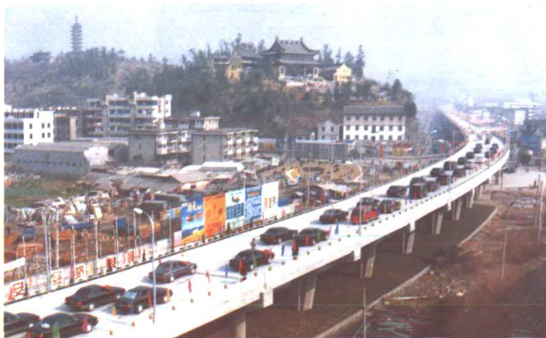
▷瑞安市区 104 国道高架桥
