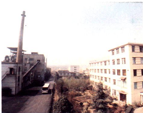
建于1986年的嵊县发电厂全貌
