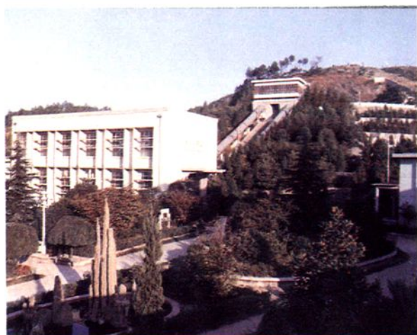
建于1981年的新昌县棣山水电站外观
