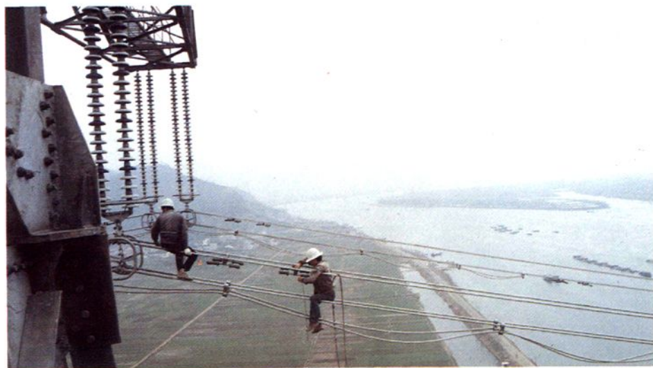
1990年线路工人 在跨富春江的500 千伏线路上作业
