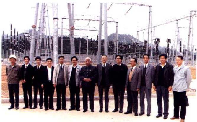
1991年5月10日上海经济开发区主任王林(左7)由华东电管局长周祥根(右6)、浙江省电力局长张蔚文(左6)和绍兴电力局长张奕模(右5)陪同视察500千伏兰亭变电所
