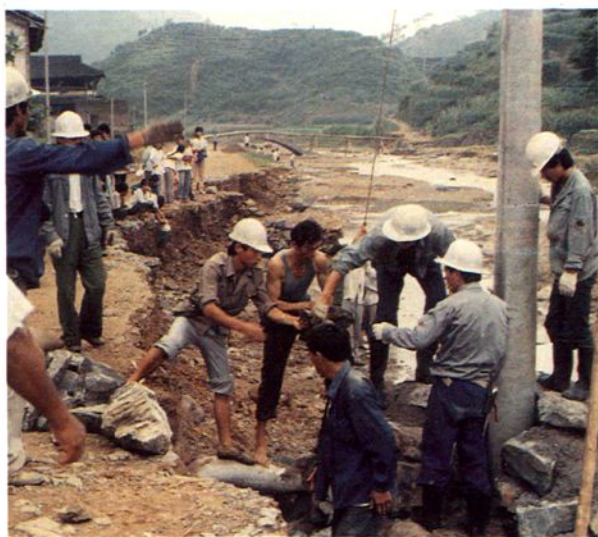
1988年8月8日诸暨供电局职工正在抢修被洪水 冲倒的10千伏线路
