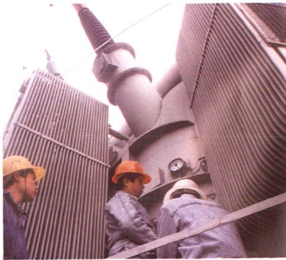
修试人员检修中的 110 千伏绍兴变主变压器
