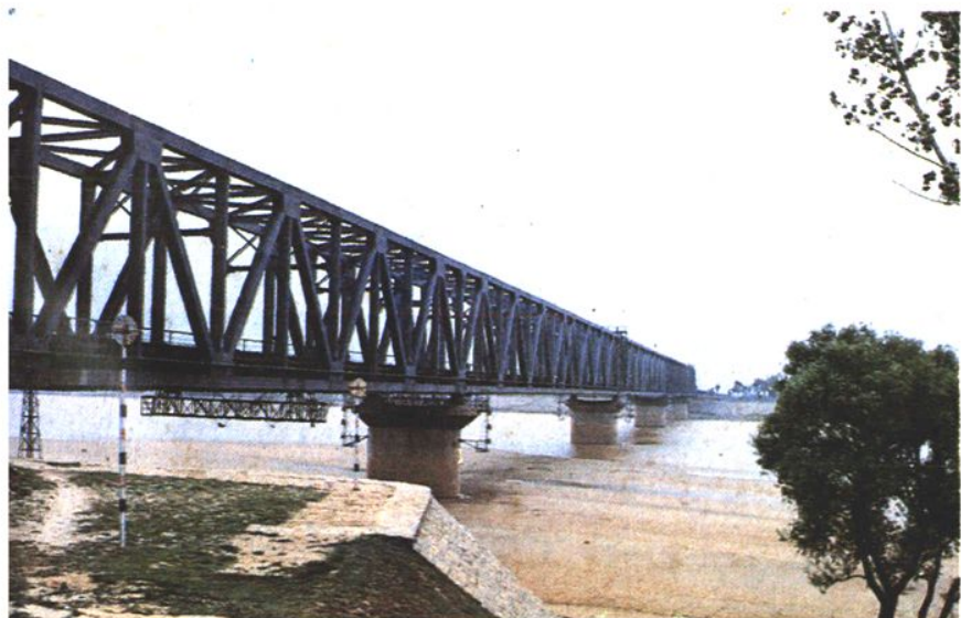
曹家圈铁路大桥
