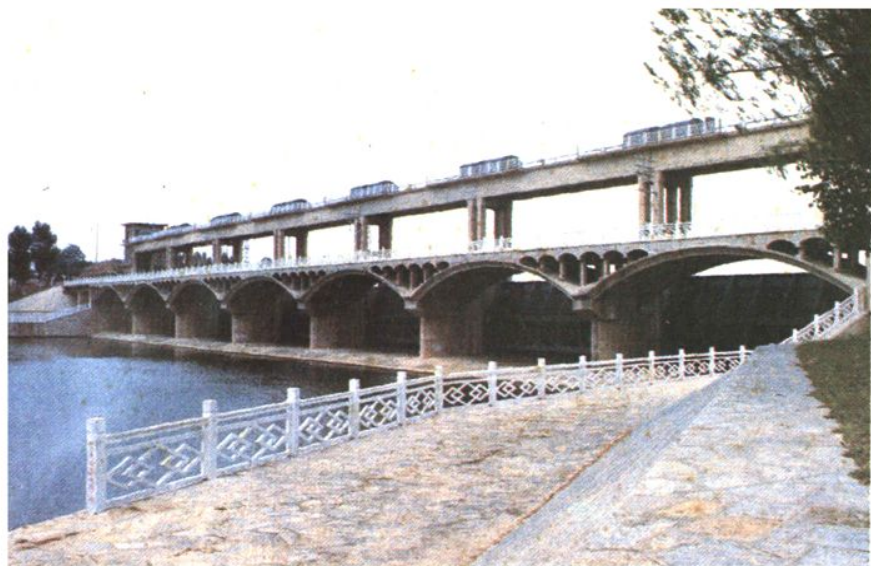
齐河豆腐窝分洪闸
