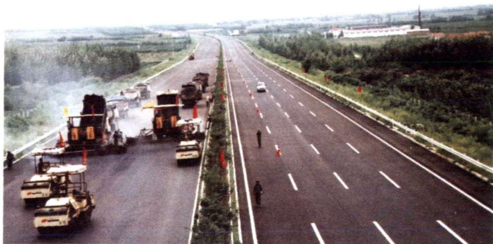
正在施工的沈大高速公路
