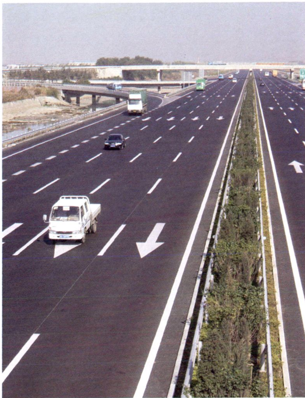
改造后的沈大高速公路
