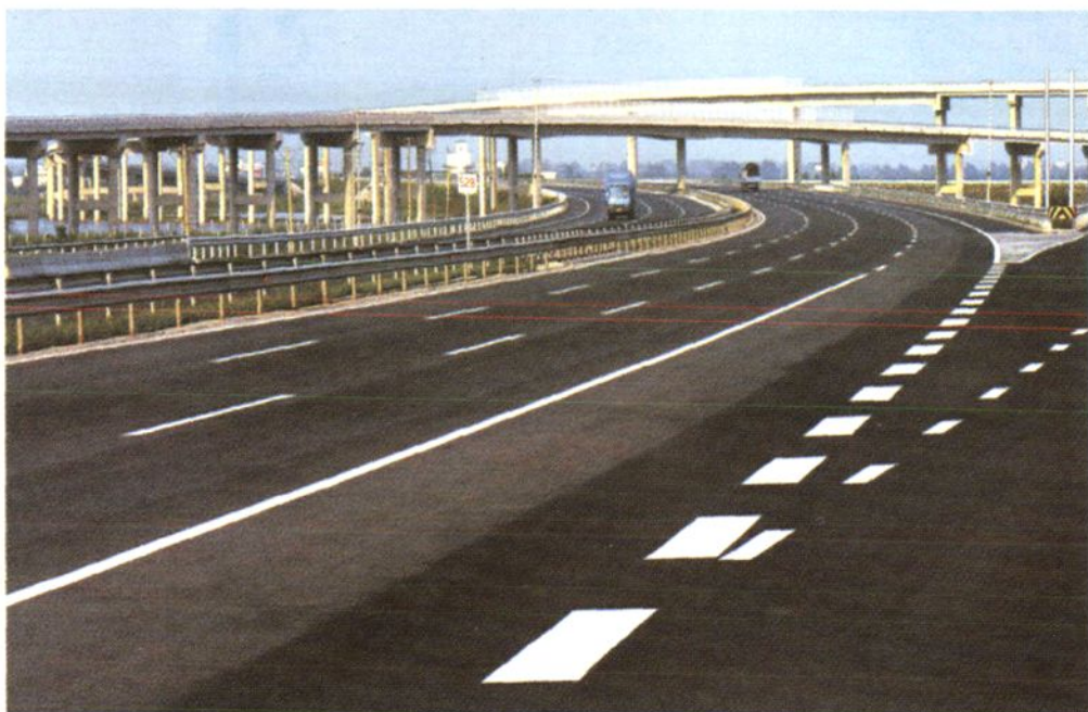
绕城高速公路李官立交桥
