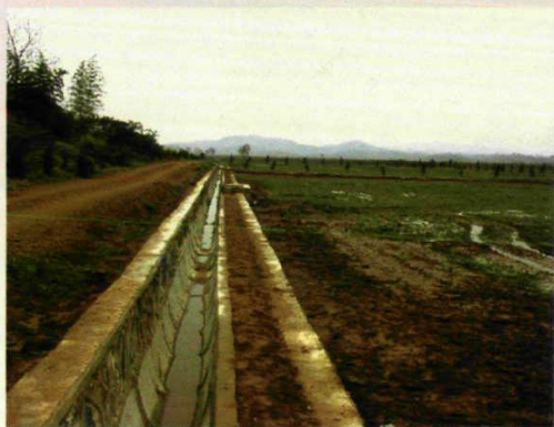
涪水县农业综合开发土地治理项目示范片
