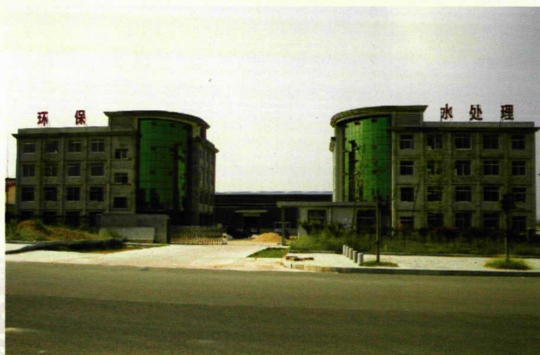
县污水处理场
