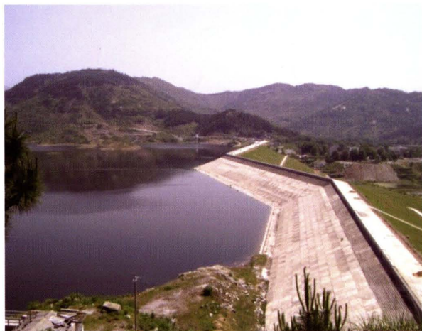
整险加固后的花园水库大坝 (2007年摄)
