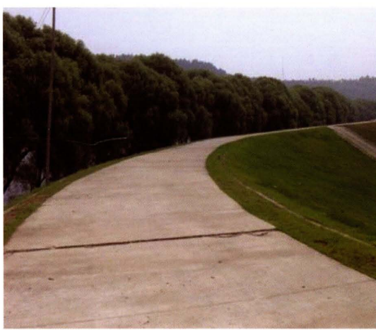
整险加固后的二里湖堤段 (2007年摄)
