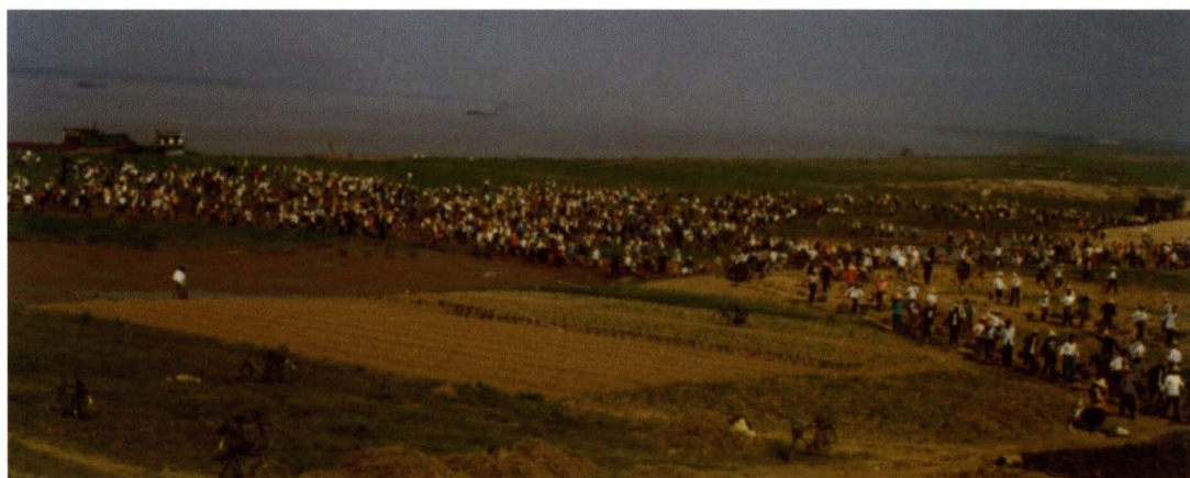
1995年，双沟大堤整险工地
