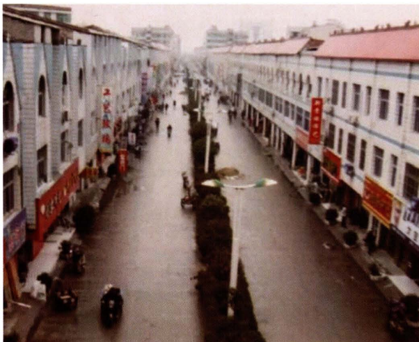
漕河城区电力街（2007年摄）
