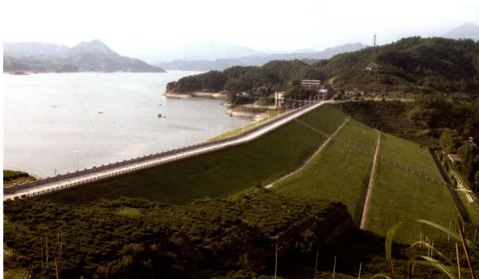
整险加固后的大同水库大坝 (2007年摄)
