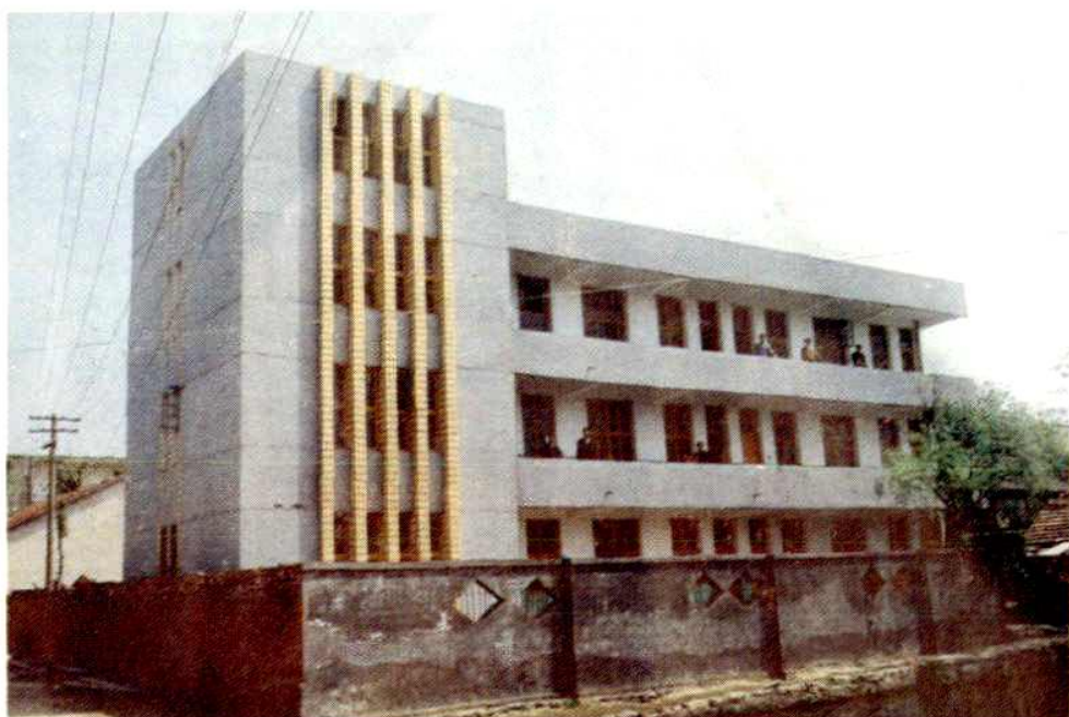
新洲粮食职工学校教学大楼
