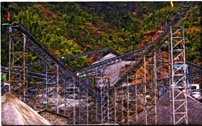
正在建设中的槟榔江水电站
