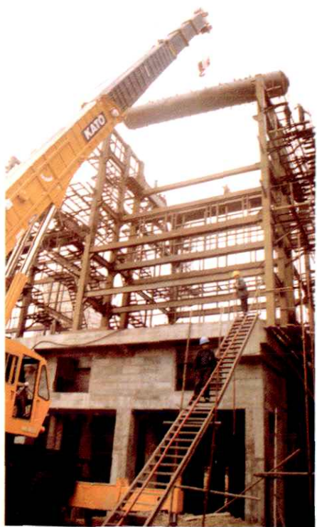
75吨/时锅炉汽包吊装就位
