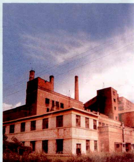
1965年兴建的火力发电机组厂房旧址 (1×750+1×1500千瓦)
