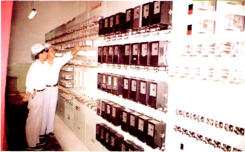
华能火电设备安装工程公司安装调试发电保护装置
