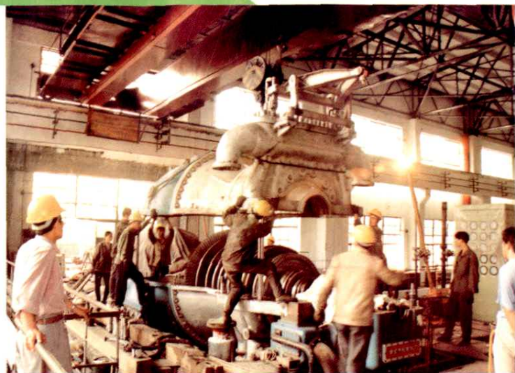
1.2万千瓦汽轮发电机组检修
