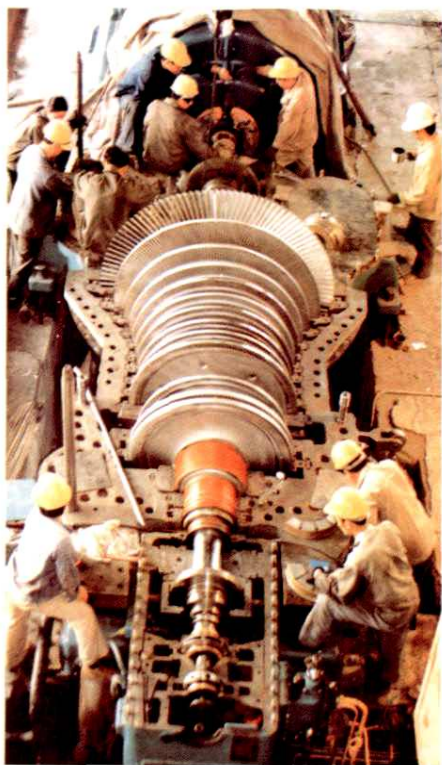
1.2万千瓦汽轮发电机组安装现场
