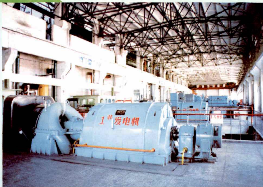
汽轮发电机组厂房 (装机 3.6 万千瓦)
