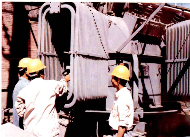
变压器安装
