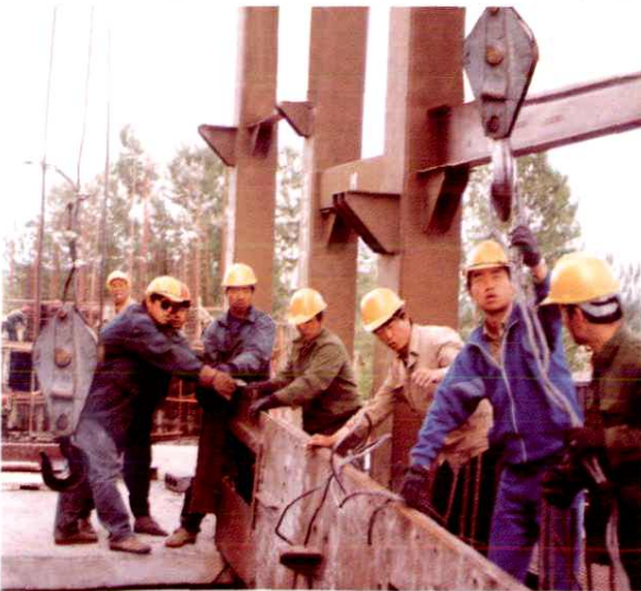
华能火电设备安装工程公司安装 75 吨 / 时锅炉钢架吊装
