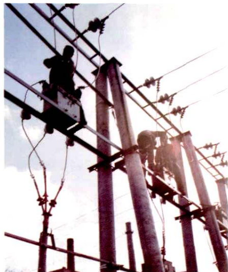
输电线路检修
