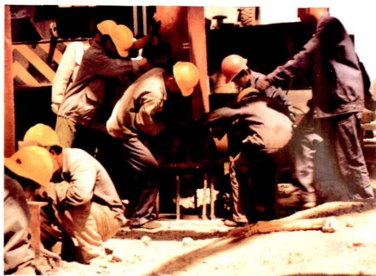
75吨/时锅炉钢架就位
