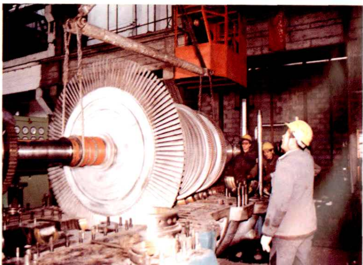
1.2万千瓦汽轮机转子吊装就位
