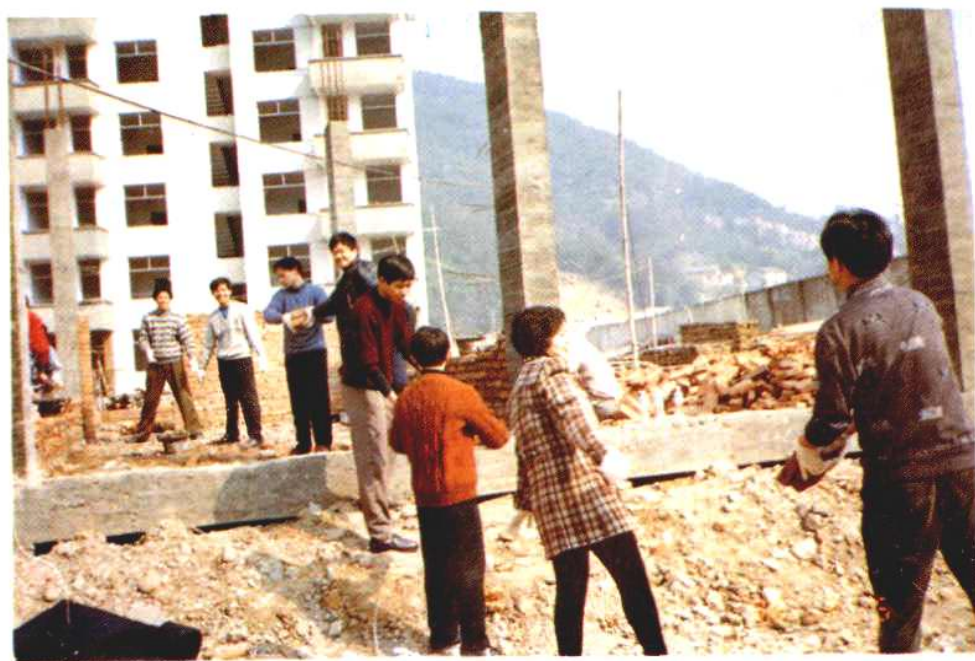
县检察院团支部组织团员为检察办公大楼添砖加瓦。 后为干部宿舍楼基建工程。
