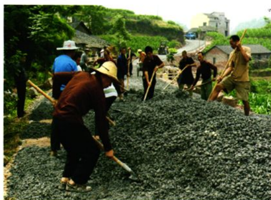
乡村公路油化施工
