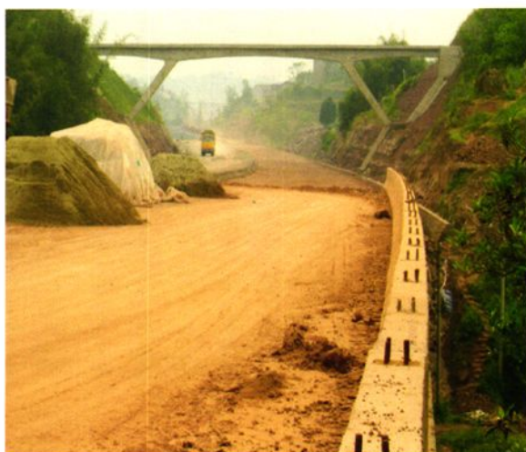
建设中的南渝高速公路武胜段
