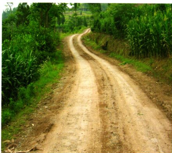
使用中的村级公路
