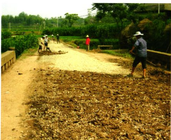
村级公路加铺碎石面层
