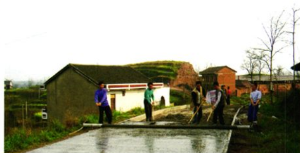
新农村公路硬化施工
