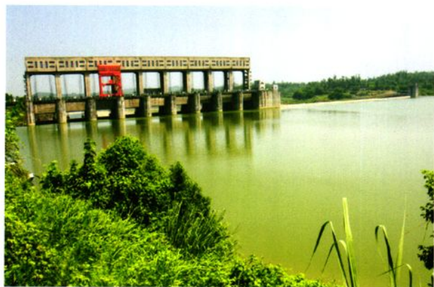
嘉陵江东西关航电枢纽——拦河大坝
