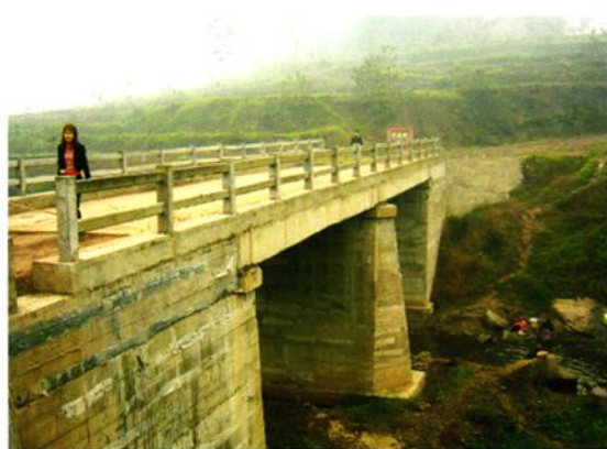
新建乡村公路桥梁
