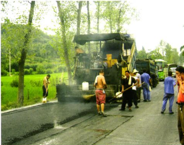
国道212线武胜段公路改造
