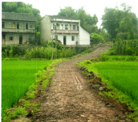
铺完碎石面层的村级公路
