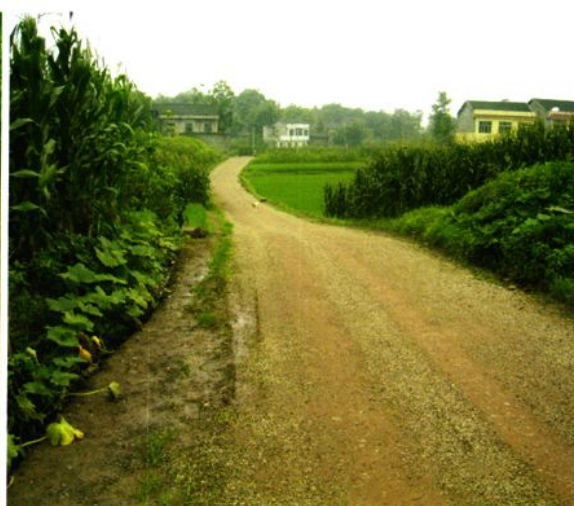
广安市首条使用康耐稳定土新技术铺设的乡村公路
