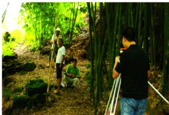
村级公路工程技术测量
