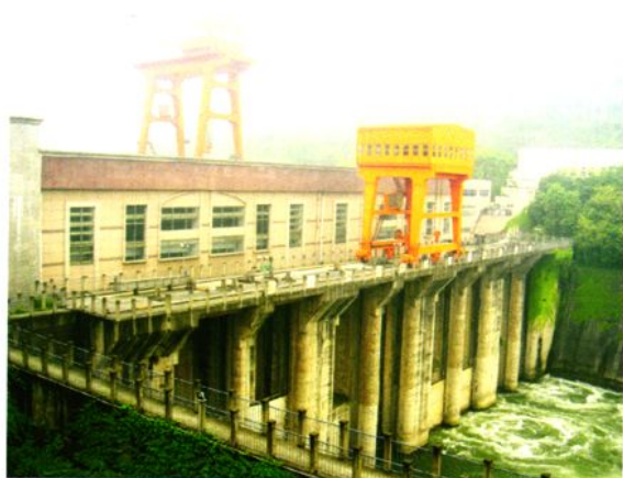
嘉陵江东西关航电枢纽——发电厂房
