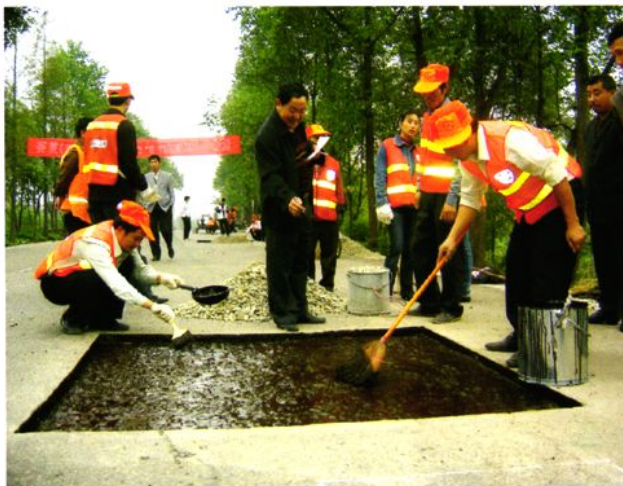
公路养护岗位技术练兵活动现场
