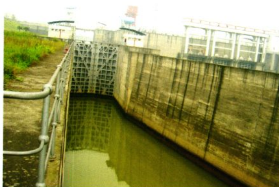
嘉陵江桐子壕航电枢纽——通航船闸
