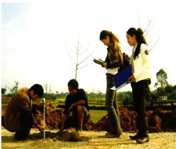
路面基础厚度测量
