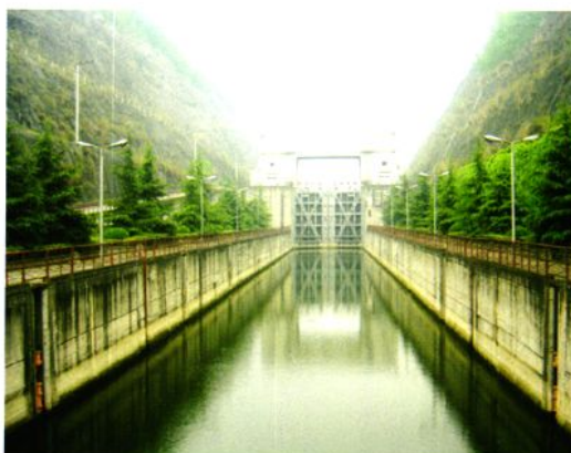
嘉陵江东西关航电枢纽——通航船闸
