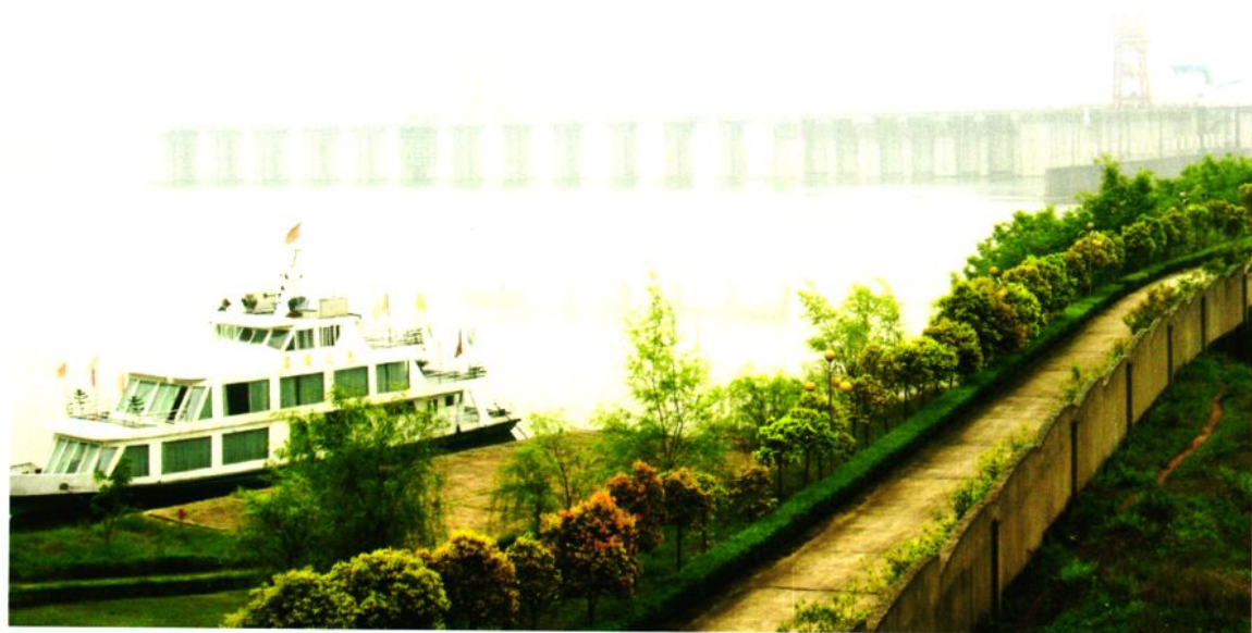
嘉陵江桐子壕航电枢纽——拦河大坝
