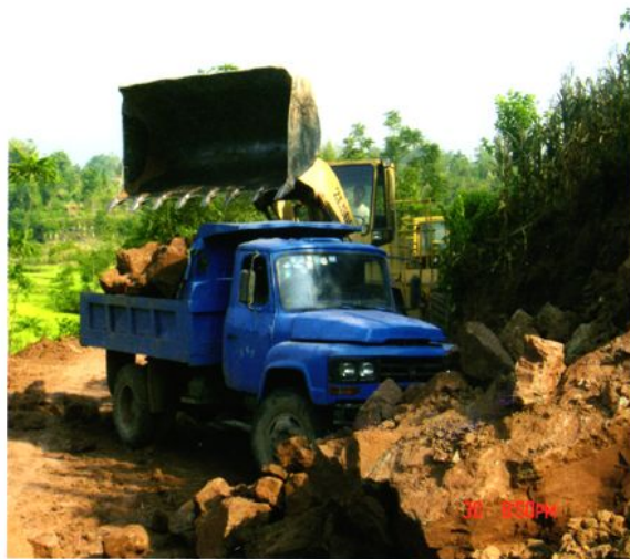
村级公路路基开挖
