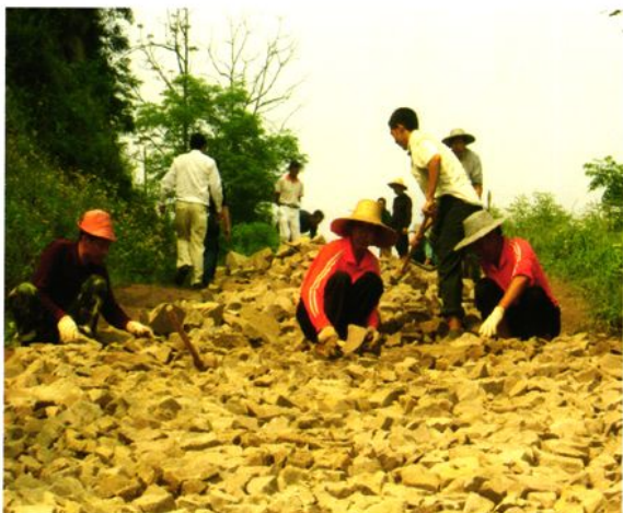
施工人员铺设村级公路片石
