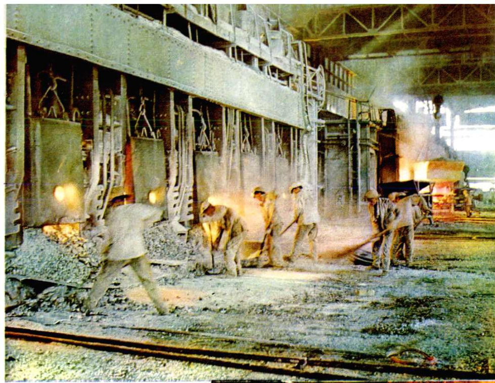
← 夺 钢 炼钢工人正在炉前奋战。目前 200 吨平炉已超装至 300 吨。
