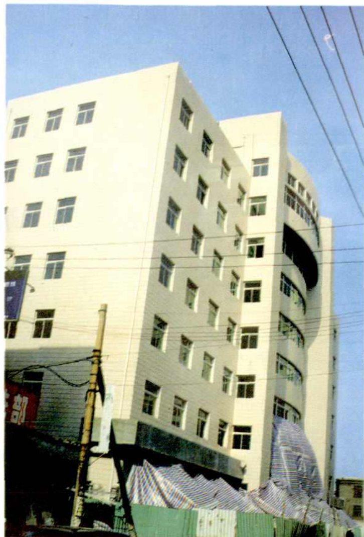
即将竣工的市 审计局办公大楼
