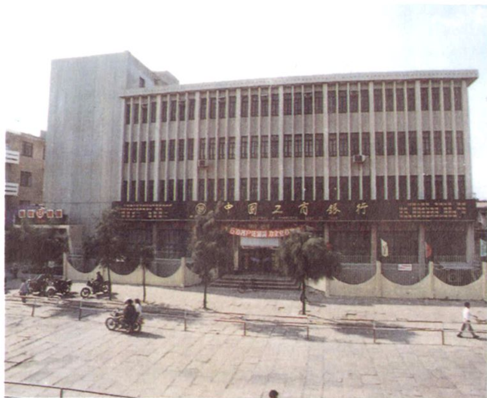
↑ 中国工商银行平潭县支行办公大楼(潭城镇东大街 73 号)
