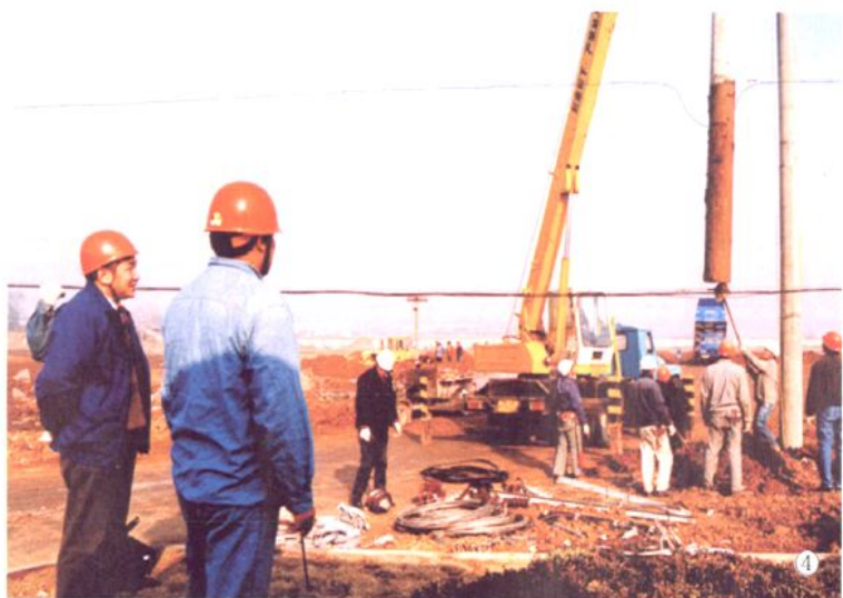
4. 1998年12月110千伏民营变电站10千伏配套工程施工现场
