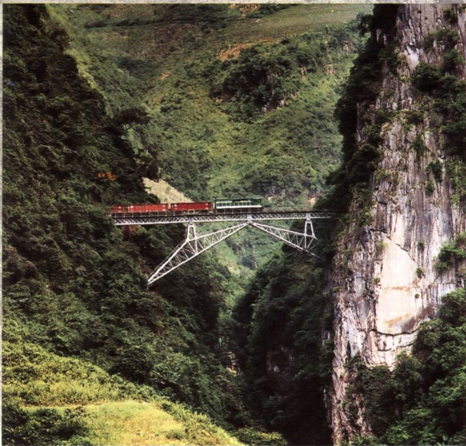
滇越铁路上的“人字桥”
