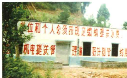
按“八有”标美站技改后的玉峰镇四口湾二级电灌站
