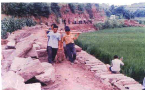
正在施工建设的乡村机耕道
