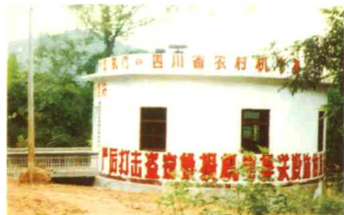
按“八有”标美站技改后的玉峰镇四口湾一级电灌站
